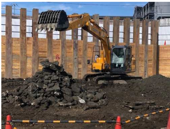
③建設工事中の地中障害物
