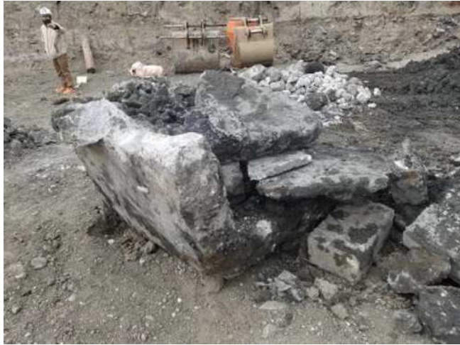
①造成中の掘削ガラ
