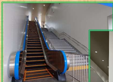
橋上駅舎への階段と 上りエスカレーター
