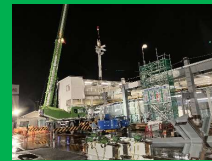
鉄骨組立(線路上空)
