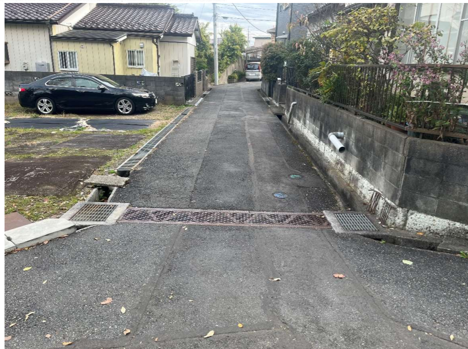
現況写真①(起点付近)
