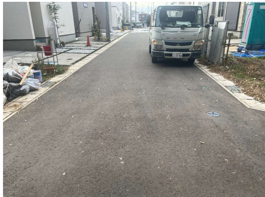
現況写真① (起点付近)
