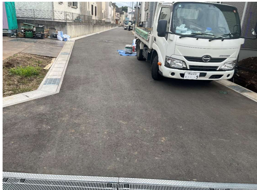
現況写真① (起点付近)
