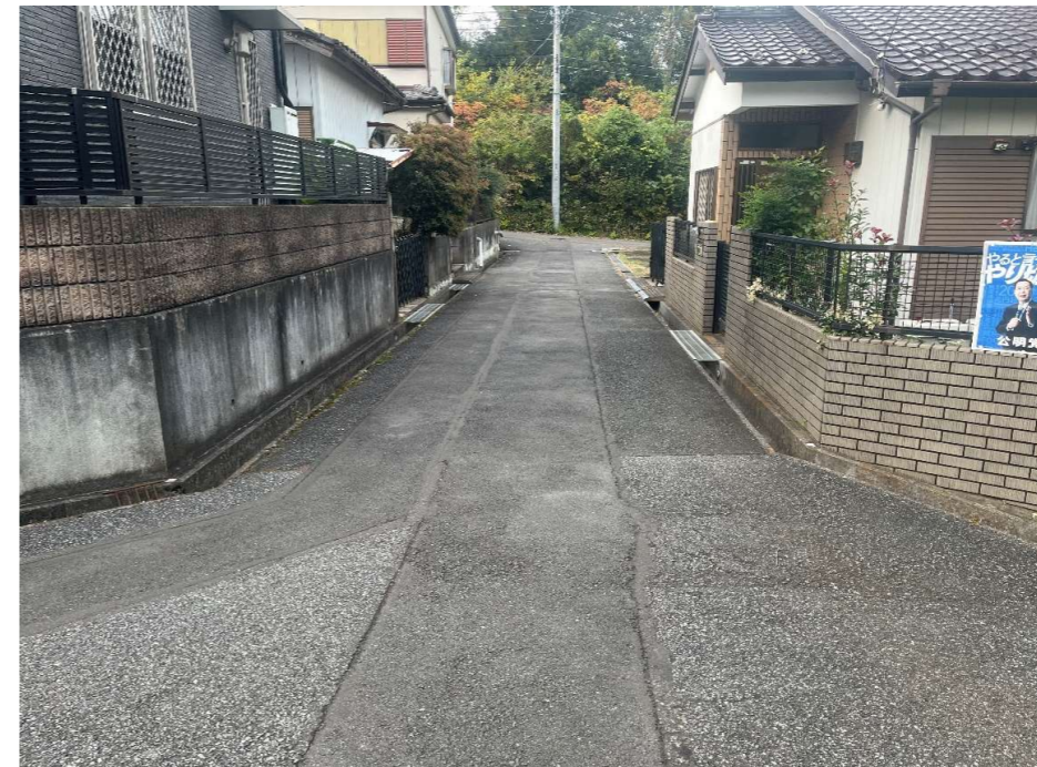
現況写真②(終点付近)
