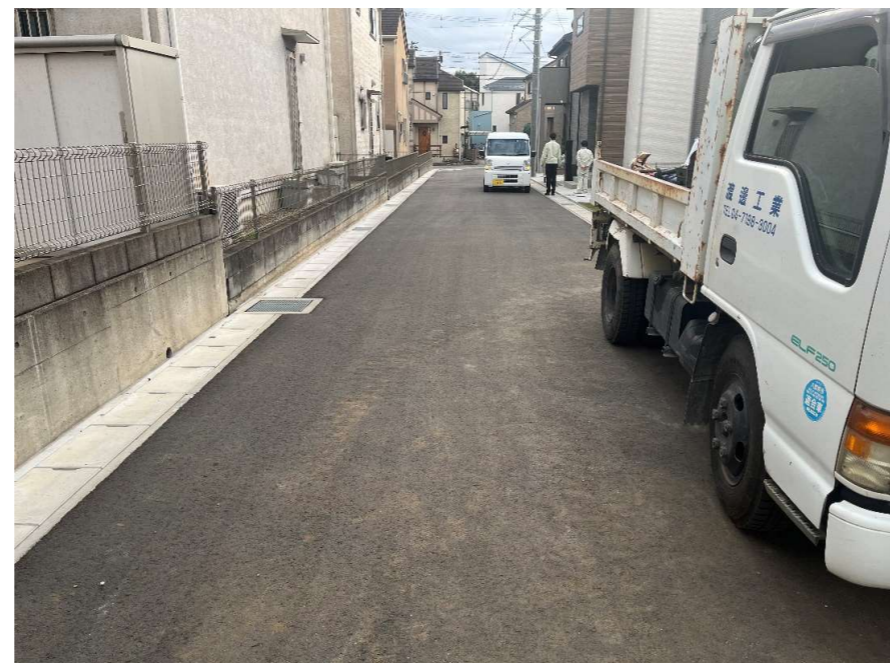
現況写真② (中間付近)
