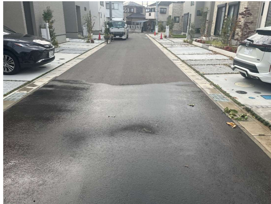
現況写真② (中間付近)
