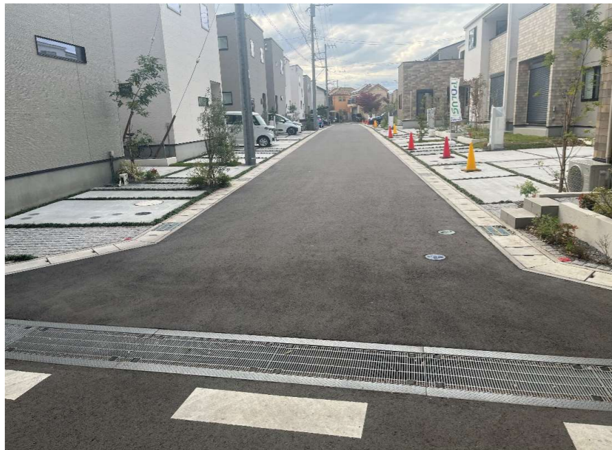
現況写真① (起点付近)
