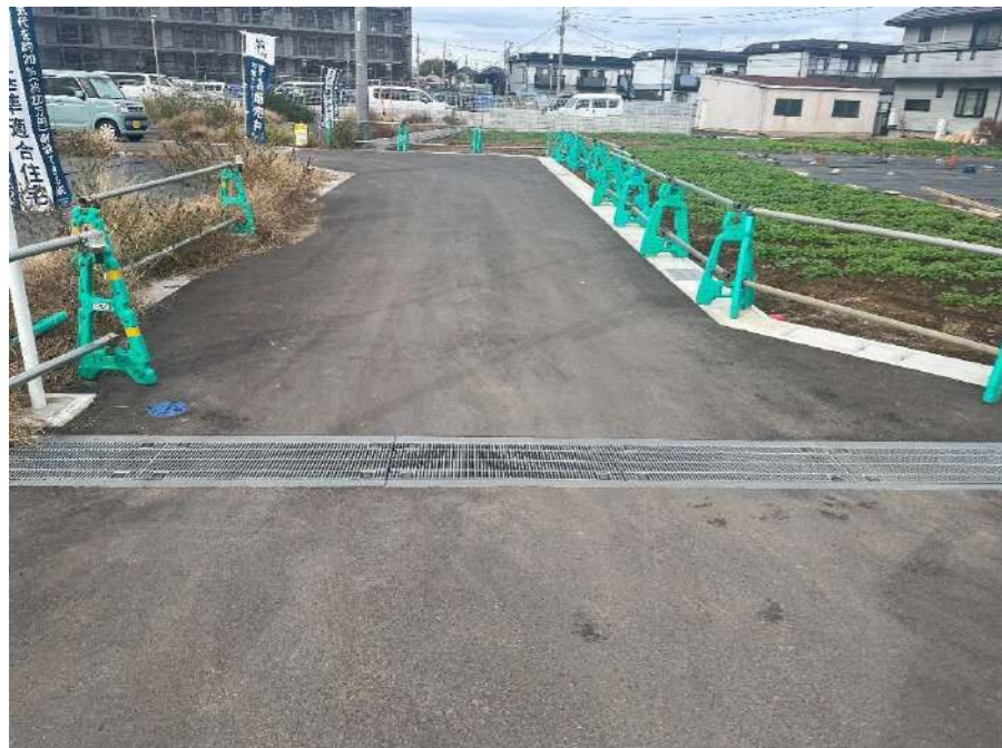
現況写真① (起点付近)
