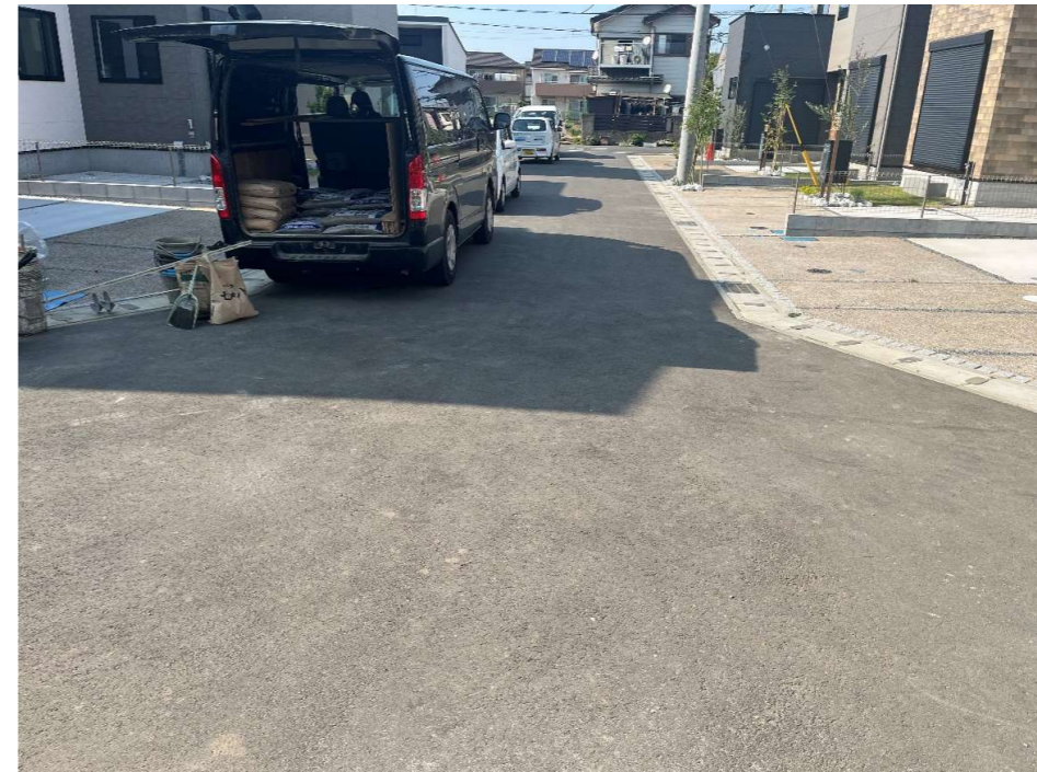
現況写真② (終点付近)
