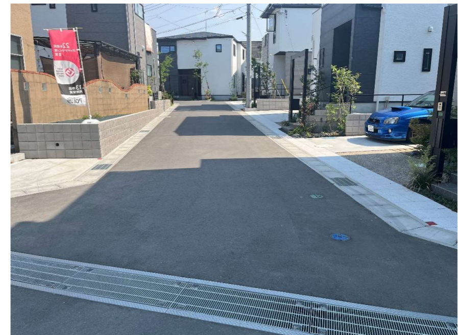
現況写真③（終点付近）
