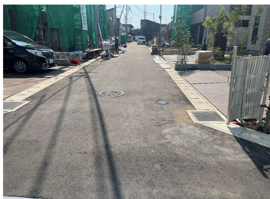
現況写真① (起点付近)
