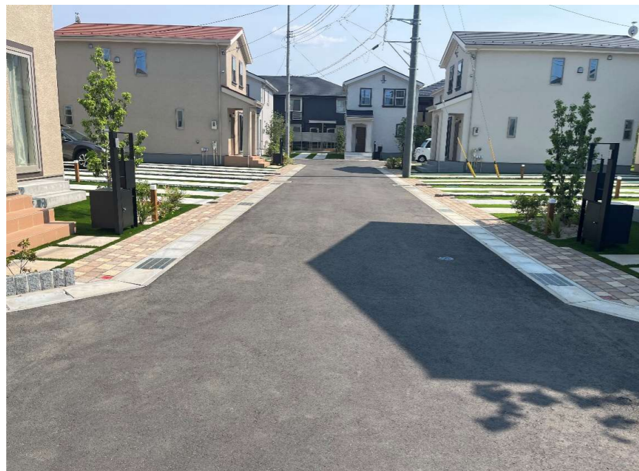
現況写真①（起点付近）
