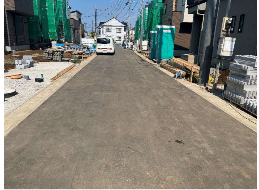
現況写真③ (終点付近)
