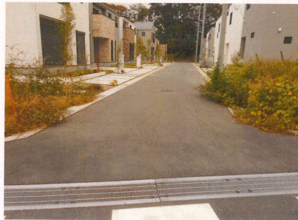
現況写真② (終点付近)
