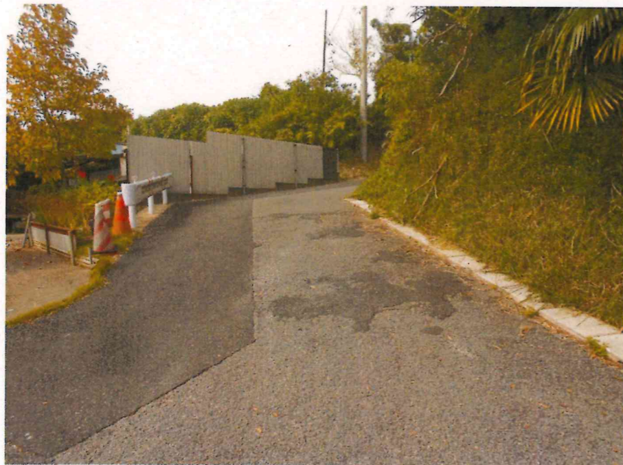
現況写真① (起点付近)
