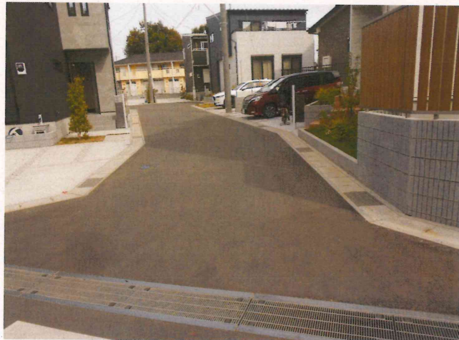
現況写真① (起点付近)
