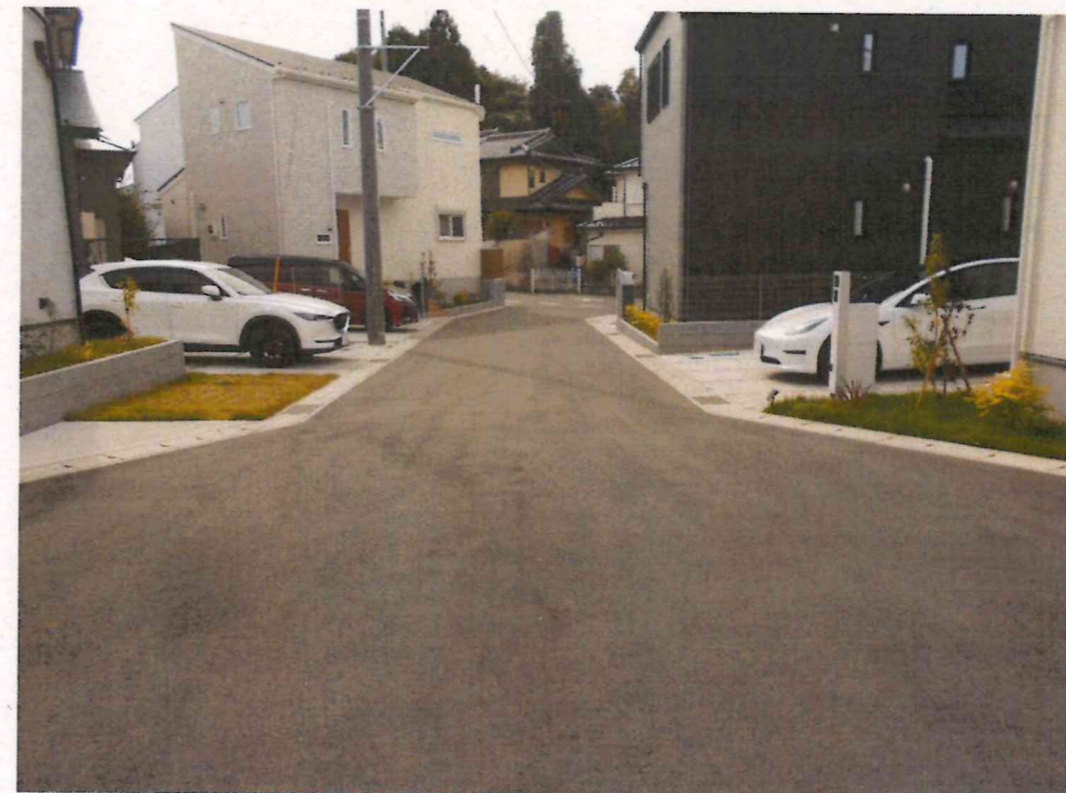
現況写真② (終点付近)
