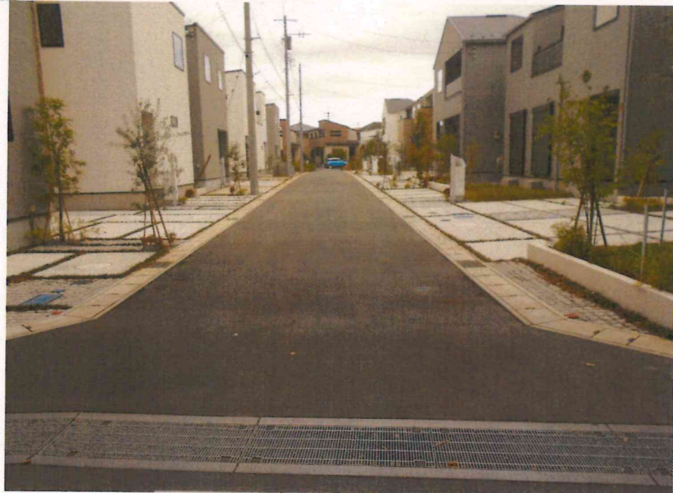
現況写真① (起点付近)
