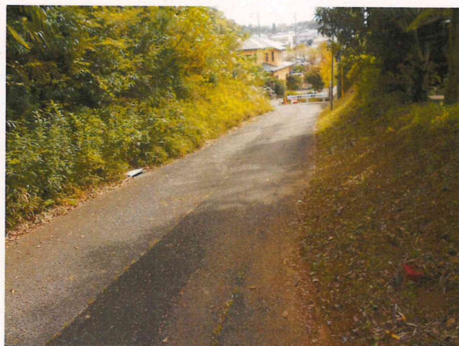
現況写真② (中間付近)
