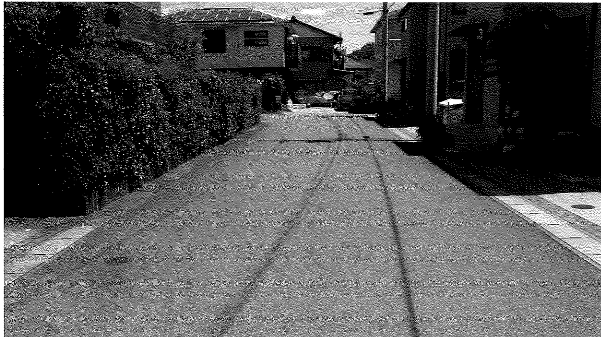
現況写真① (起点付近)
