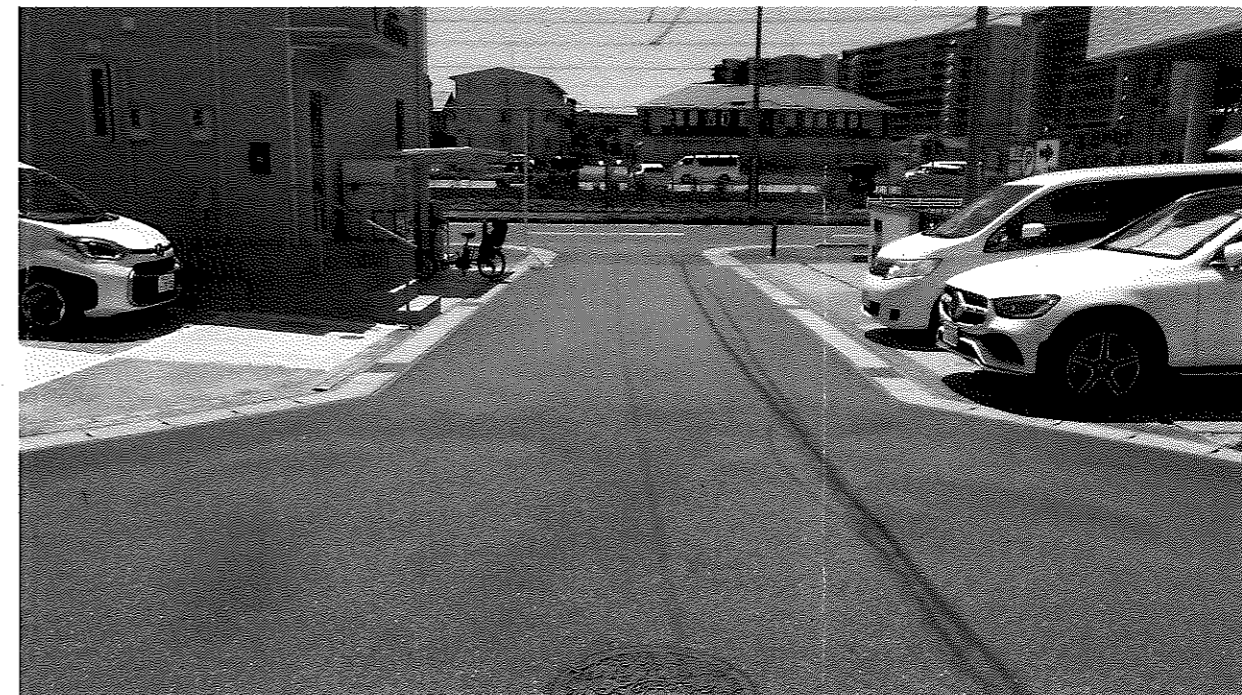
現況写真② (終点付近)
