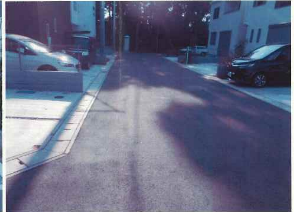
現況写真③ (終点付近)
