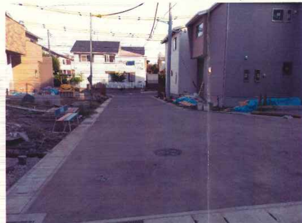
現況写真② (終点付近)
