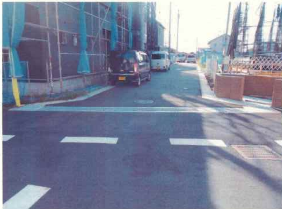
現況写真① (起点付近)
