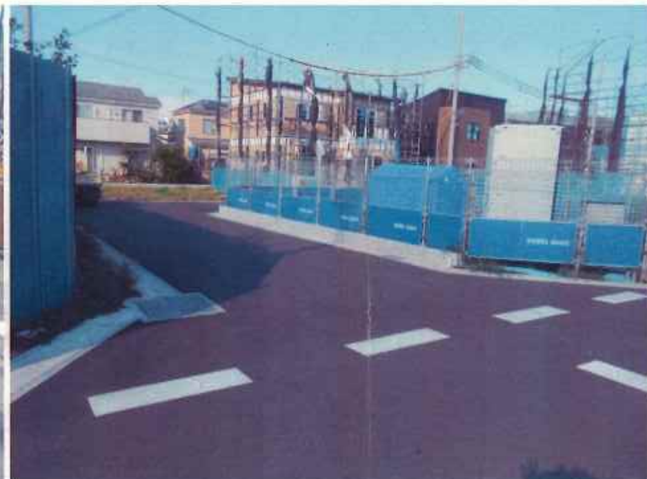
現況写真② (中間付近)
