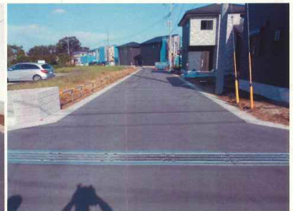
現況写真③(終点付近)
