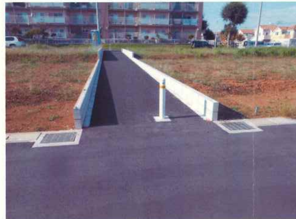
現況写真② (終点付近)
