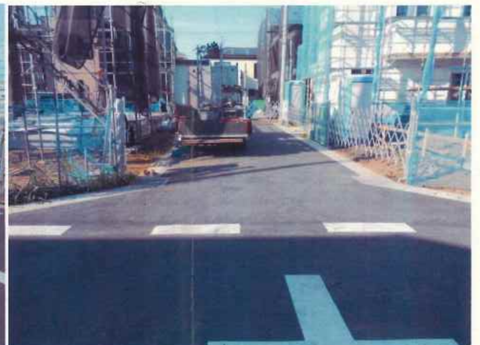
現況写真③ (終点付近)
