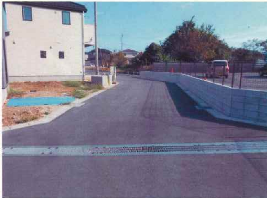
現況写真①(起点付近)
