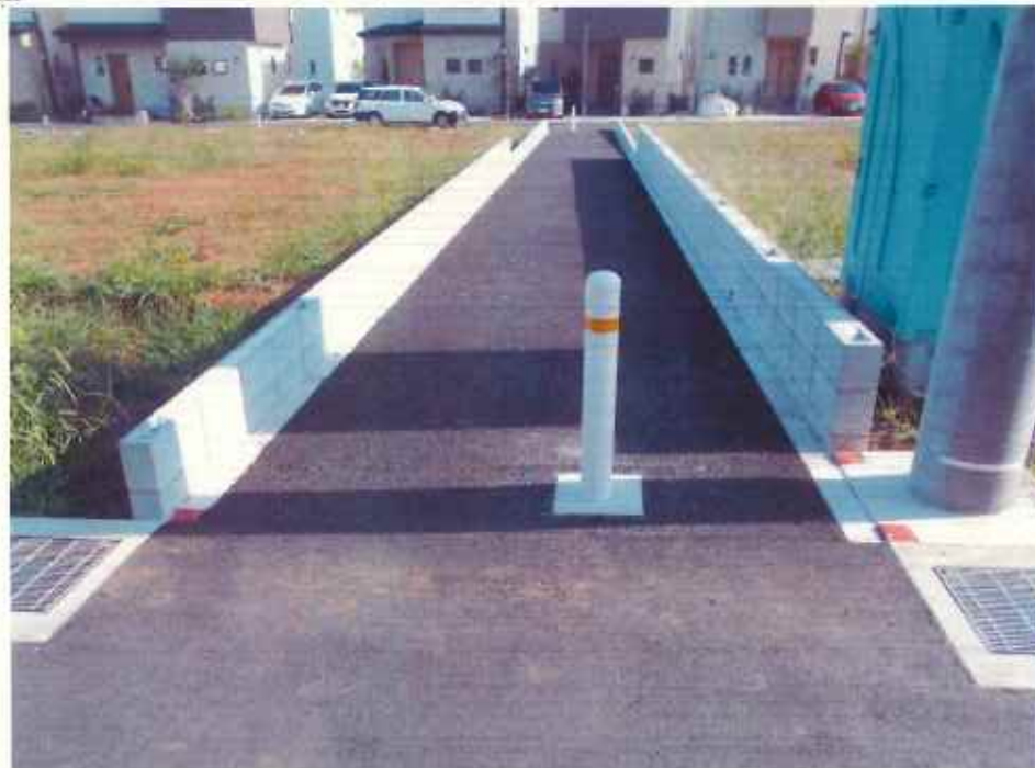
現況写真① (起点付近)
