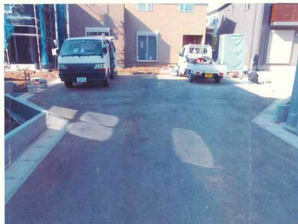
現況写真② (終点付近)
