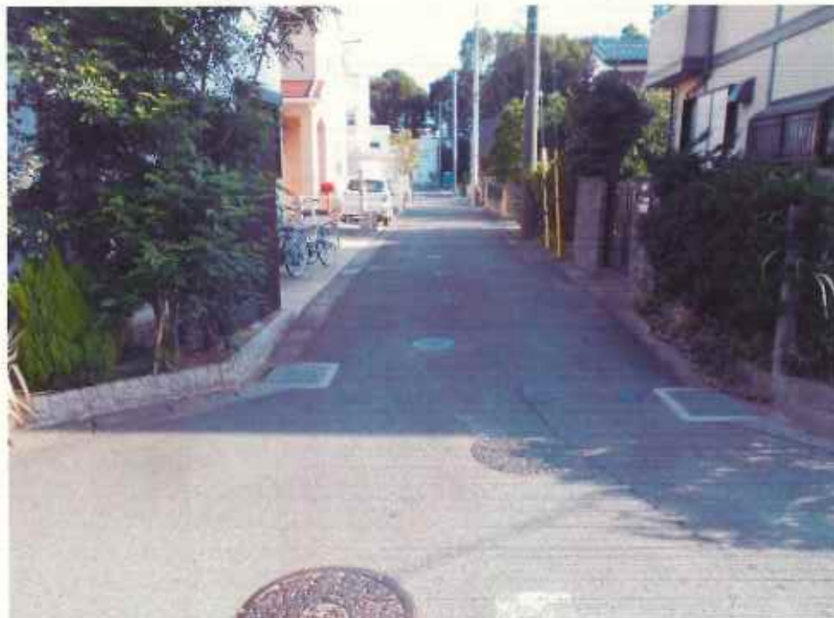
現況写真① (起点付近)
