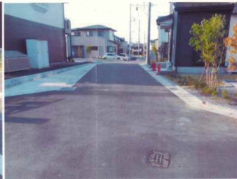
現況写真③ (77055号線終点付近)
