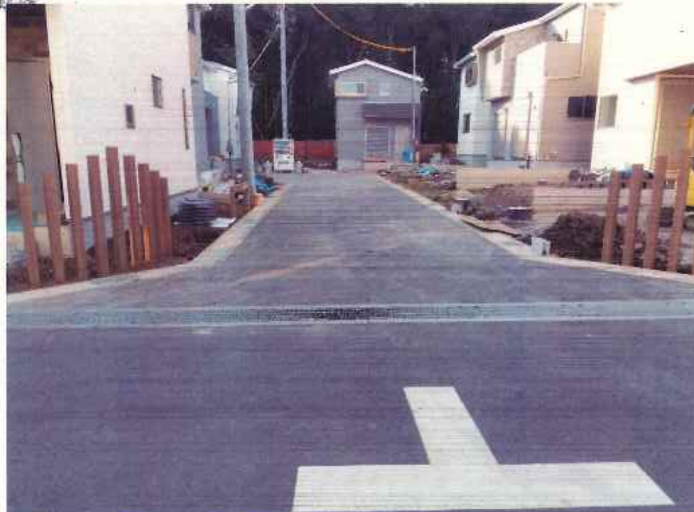
現況写真① (起点付近)
