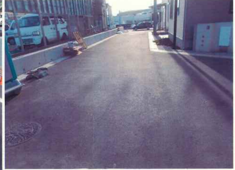
現況写真③ (71098号線終点付近)
