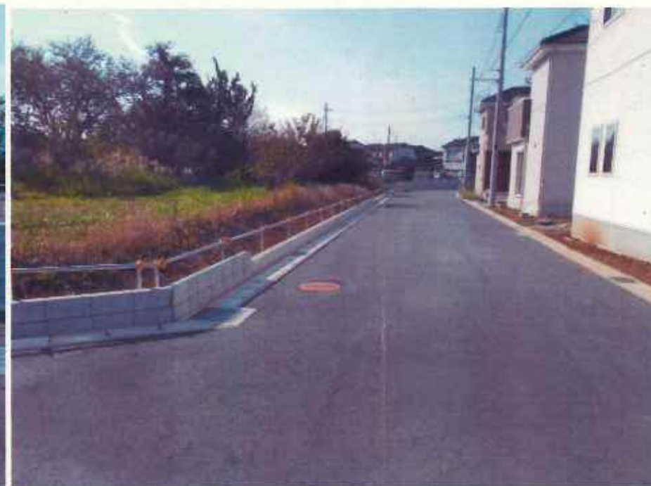
現況写真②(中間付近)
