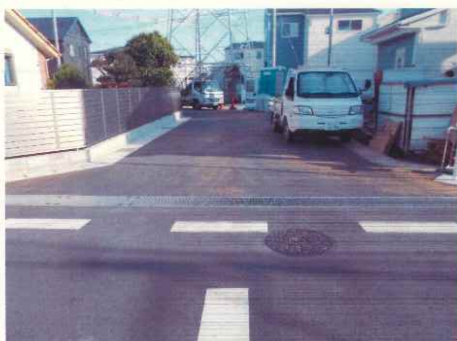
現況写真① (起点付近)
