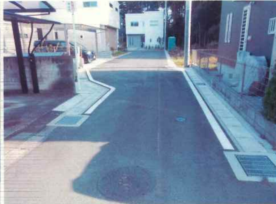
現況写真② (中間付近)
