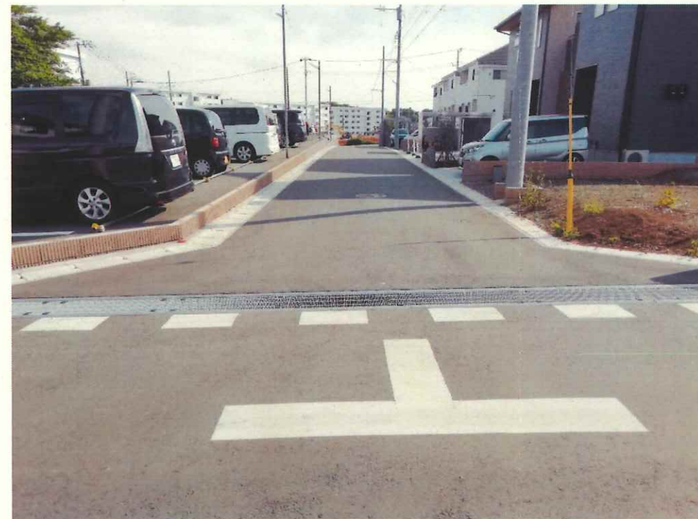
現況写真② (終点付近)
