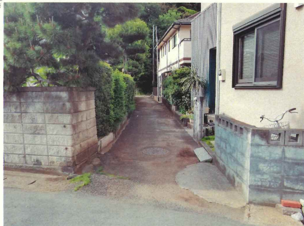
現況写真① (起点付近)
