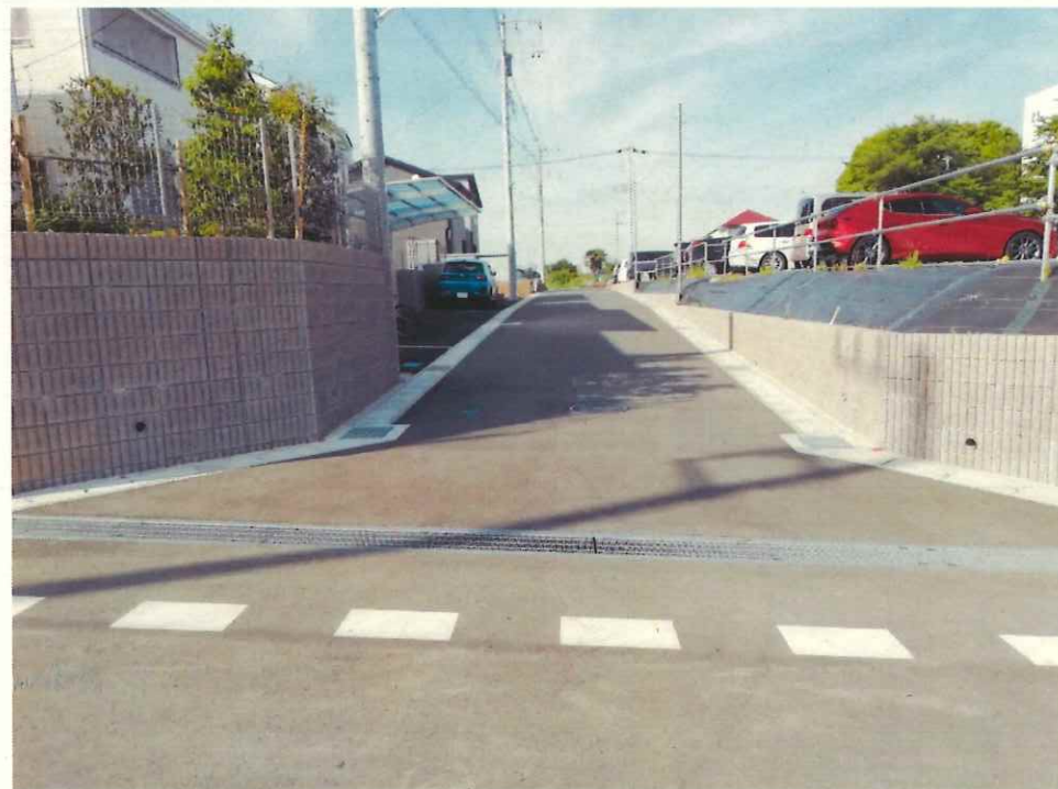
現況写真① (起点付近)
