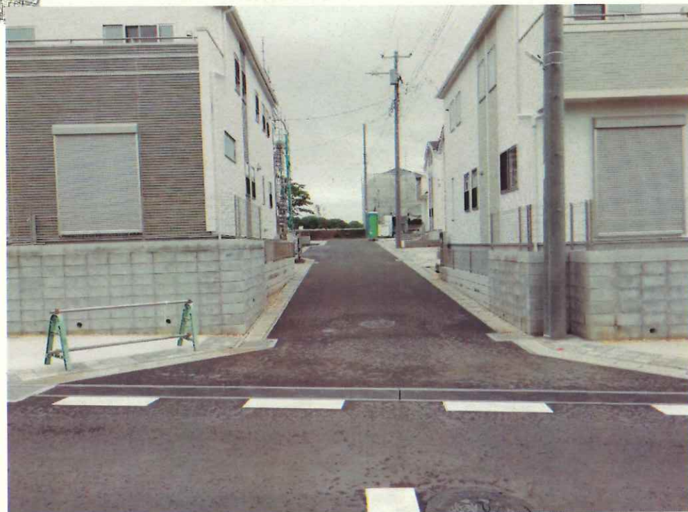
現況写真① (起点付近)
