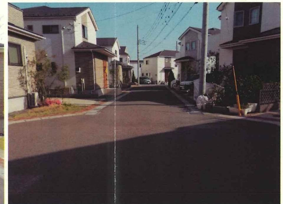
現況写真③ (終点付近)
