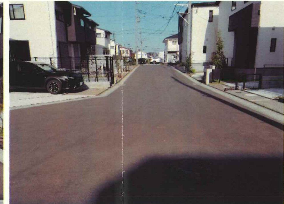
現況写真③ (終点付近)
