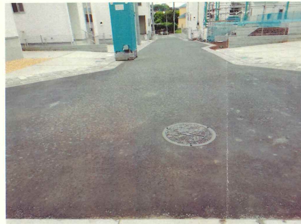
現況写真② (終点付近)
