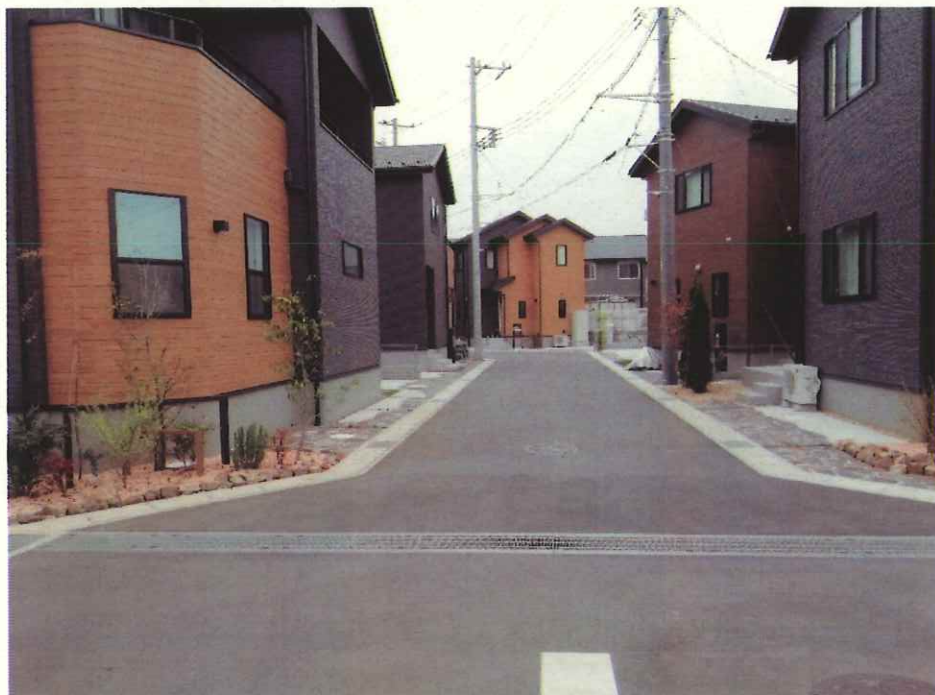
現況写真① (起点付近)
