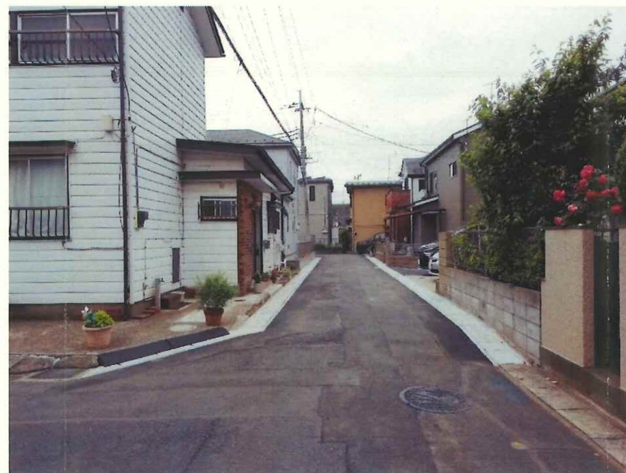
現況写真② (終点付近)
