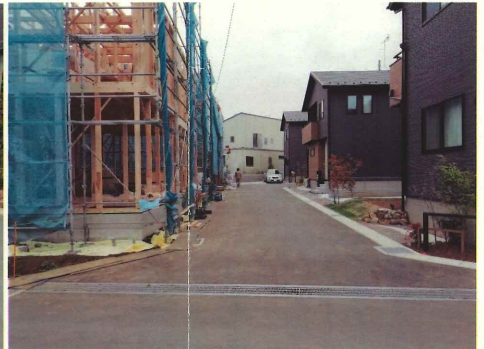
現況写真③ (終点付近)
