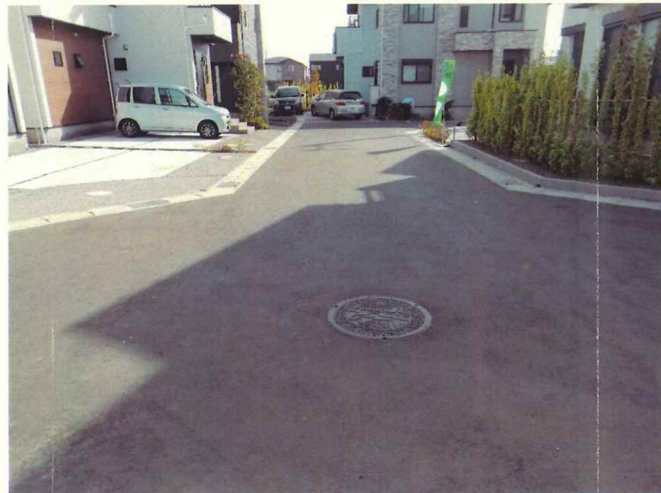
現況写真② (終点付近)
