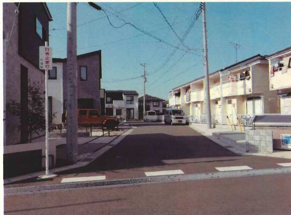
現況写真① (起点付近)
