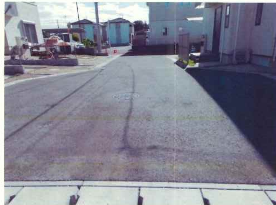
現況写真② (終点付近)
