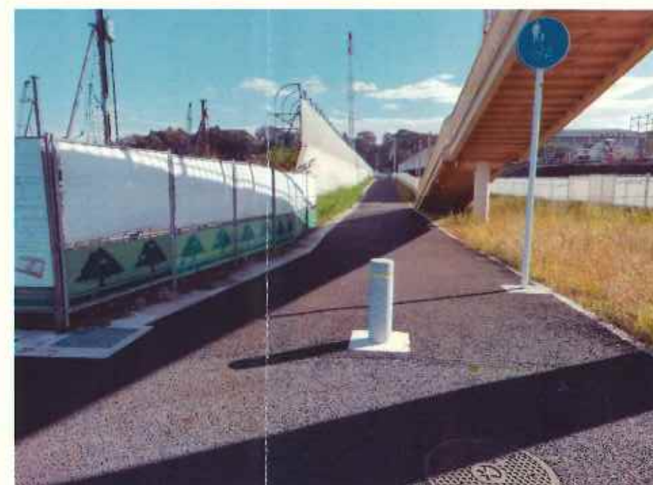
現況写真③ (06503号線起点付近)
