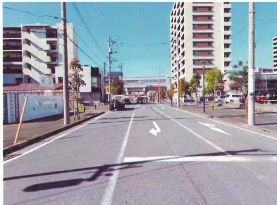
現況写真① (起点付近)
