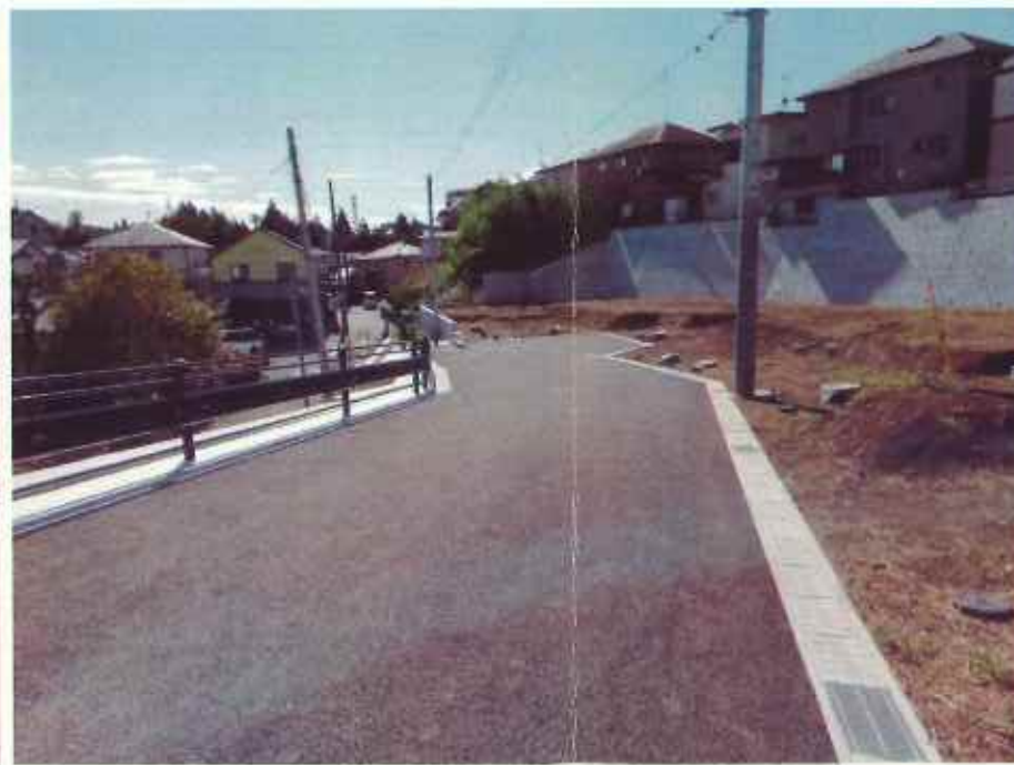
現況写真② (64026終点付近)
