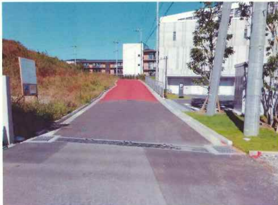
現況写真① (起点付近)
