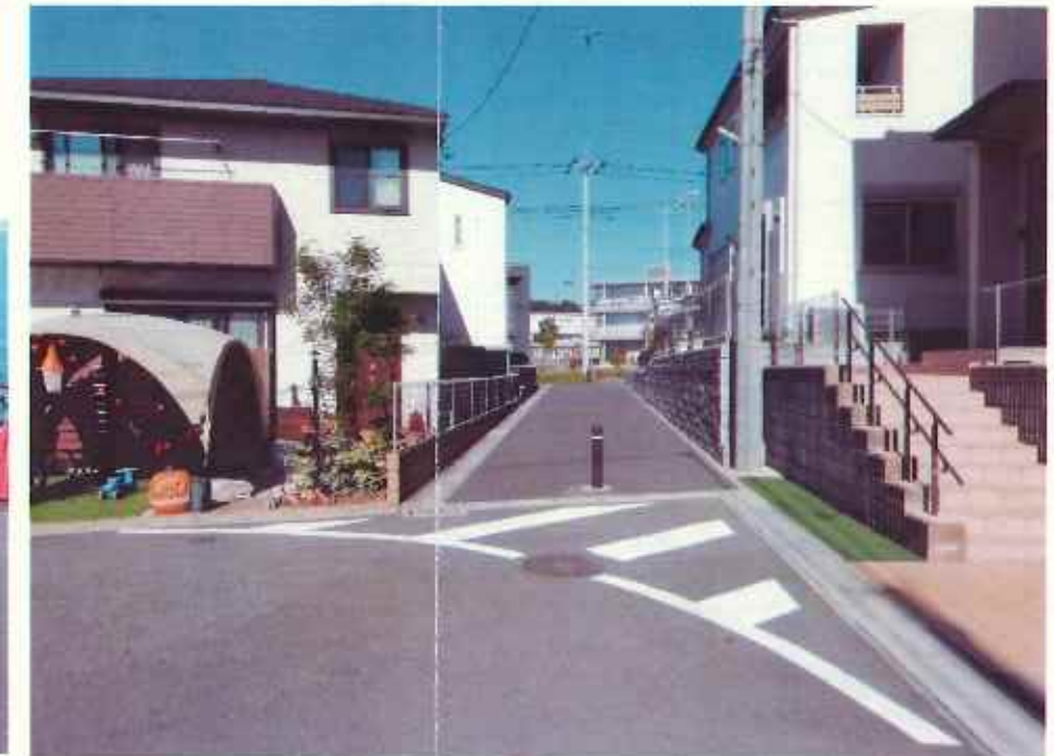
現況写真③ (40515号起点付近)
