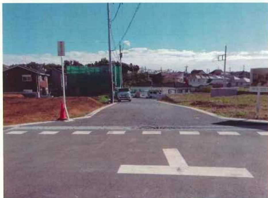
現況写真① (64026起点付近)
