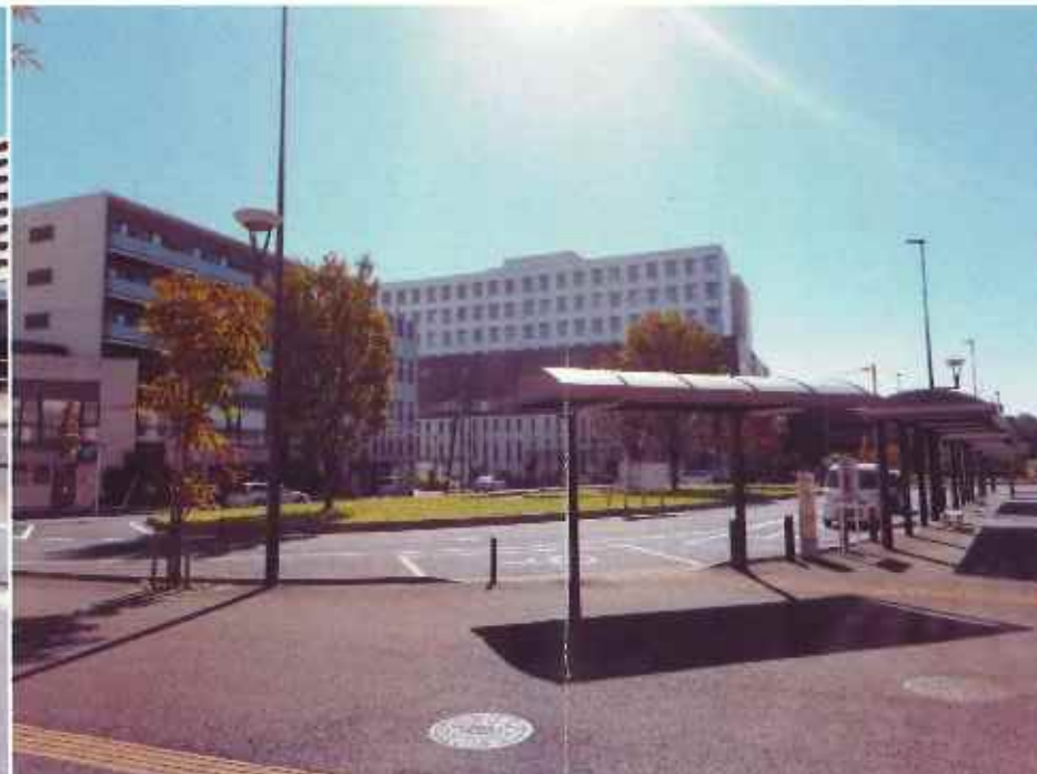
現況写真② (中間付近)
