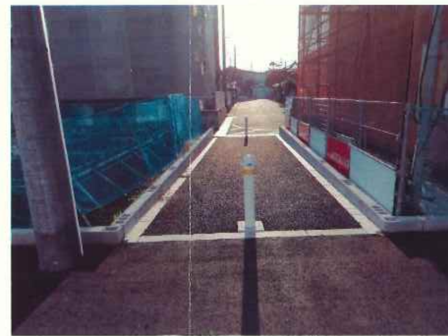
現況写真③ (07501号線終点付近)
