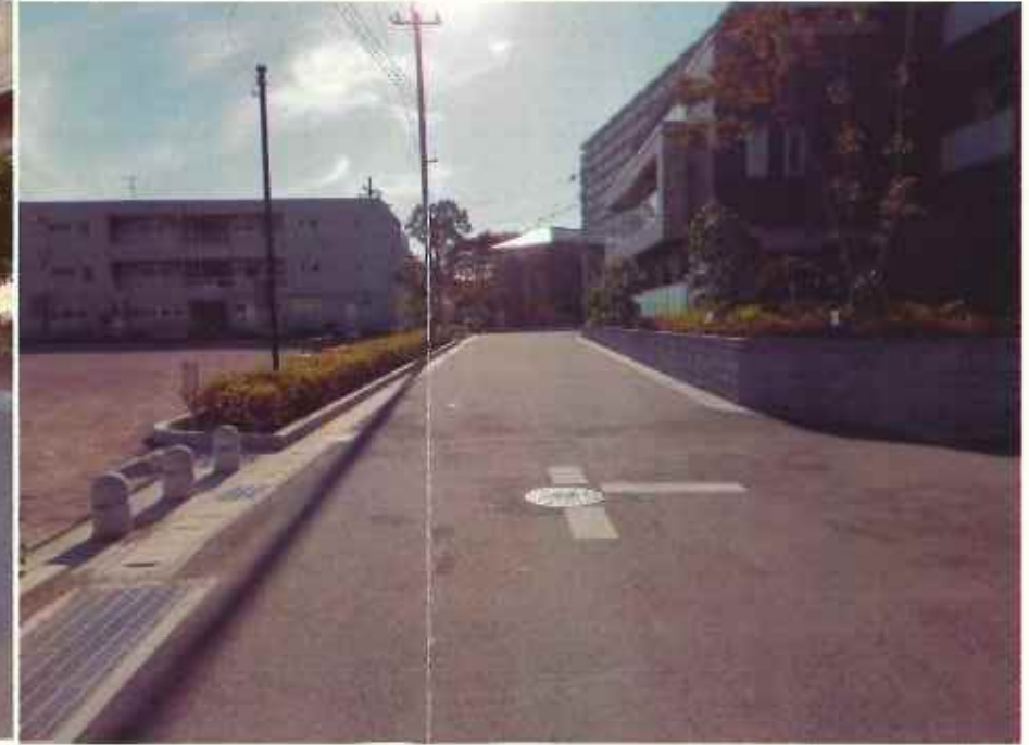
現況写真③ (81115号線起点付近)
