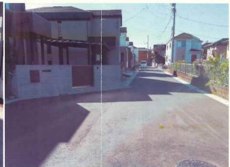
現況写真③ (終点付近)
