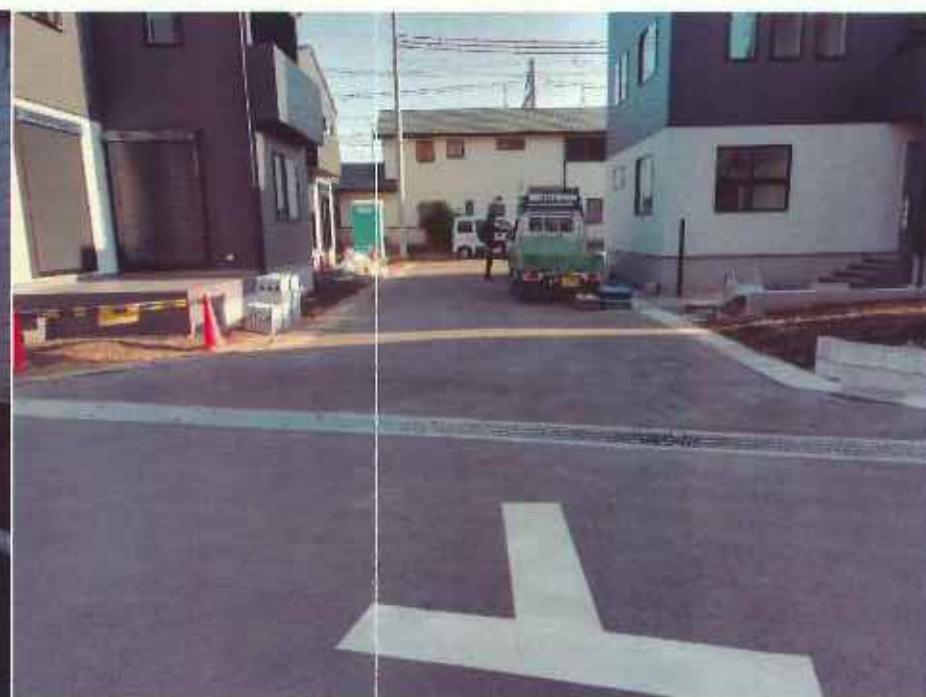
現況写真③ (終点付近)
