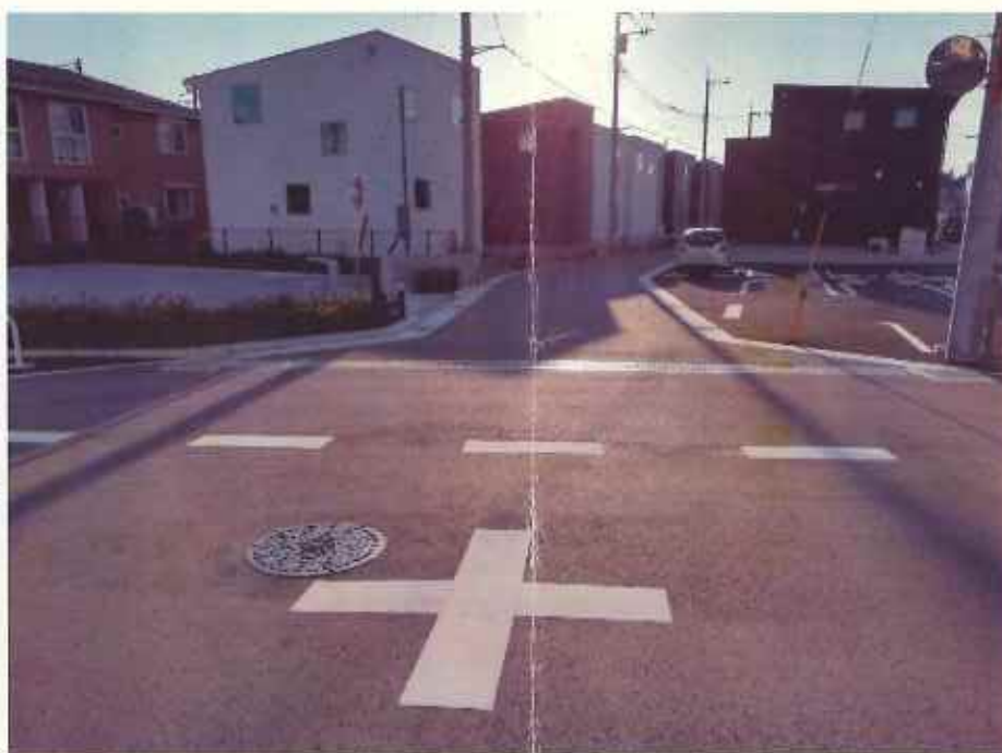
現況写真② (07053号線終点付近)
