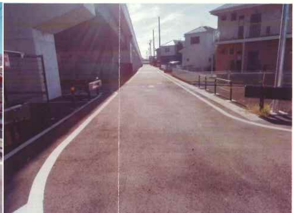
現況写真③ (81120号線中間付近)
