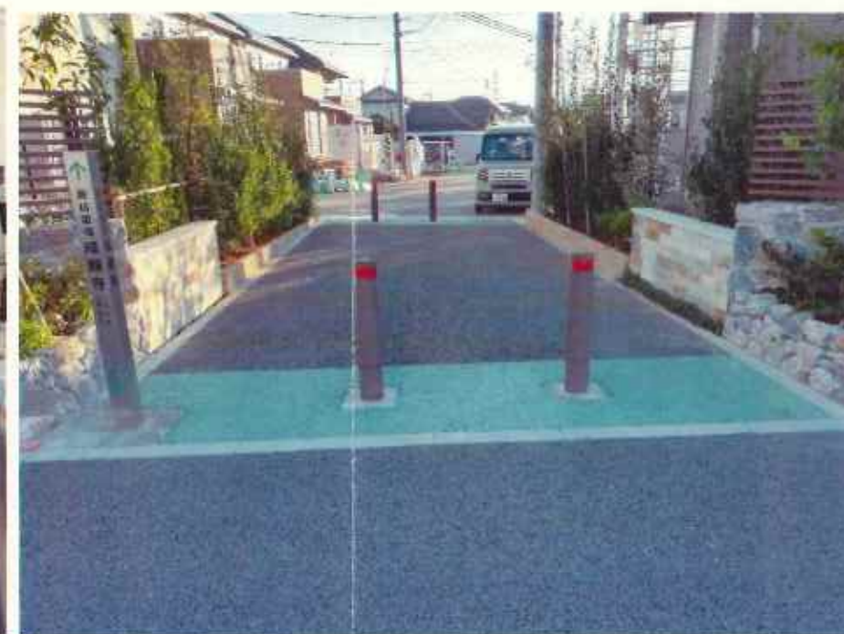
現況写真③ (38507号線起点付近)
