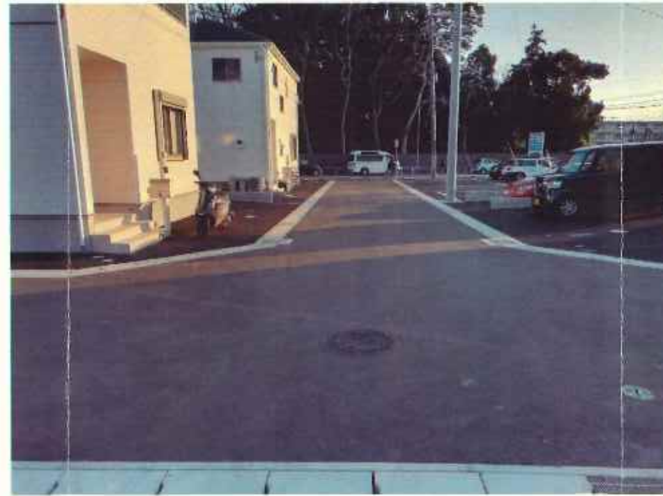
現況写真② (終点付近)
