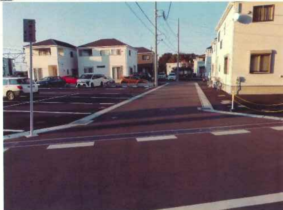
現況写真① (起点付近)
