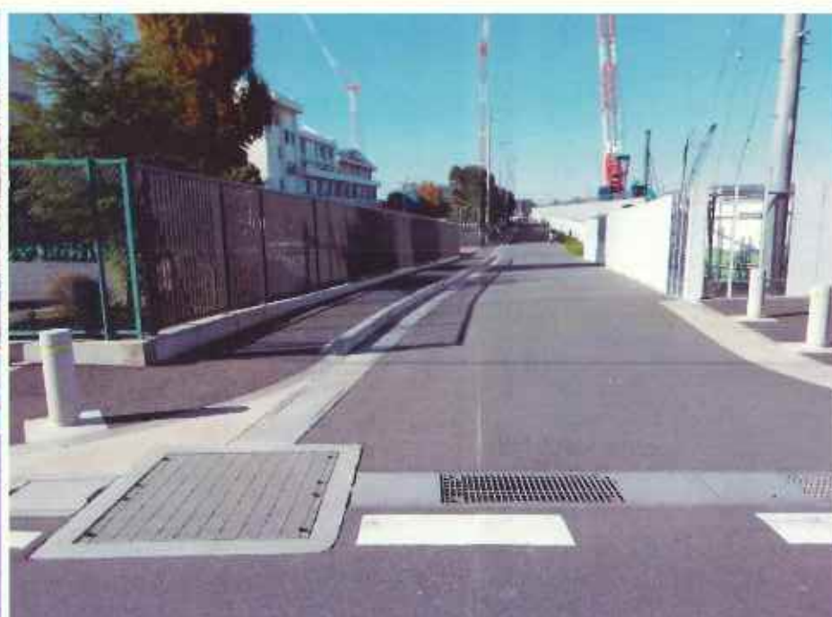
現況写真② (17047号線終点付近)
