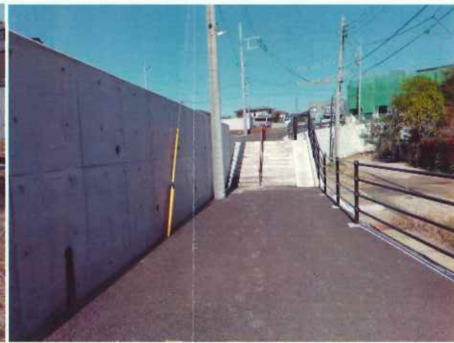
現況写真③ (64501起点付近)
