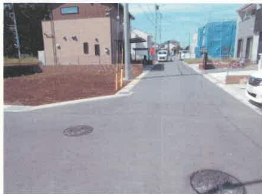
現況写真② (中間付近)
