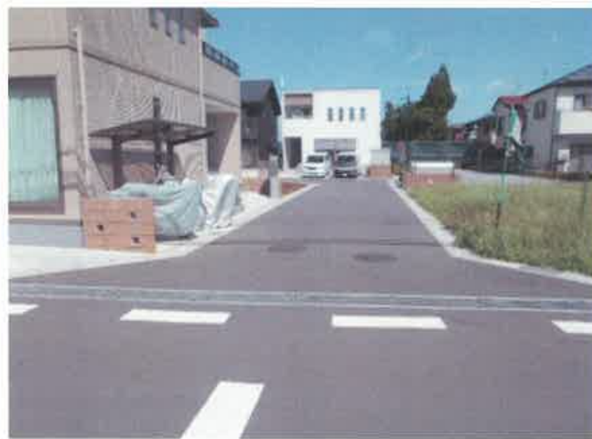
現況写真① (起点付近)
