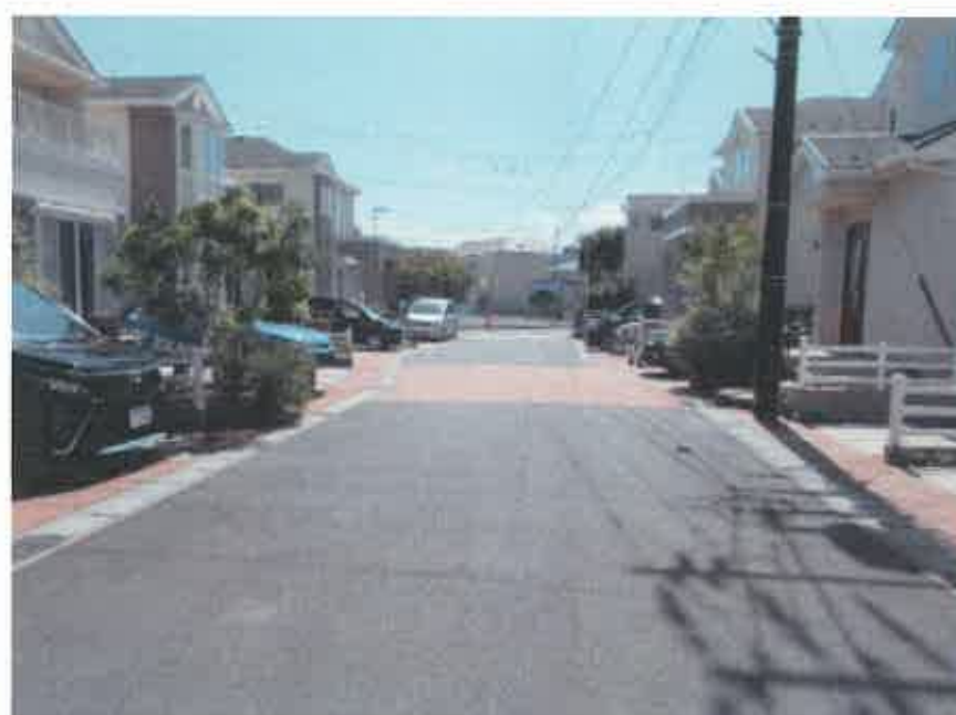
現況写真② (中間付近)
