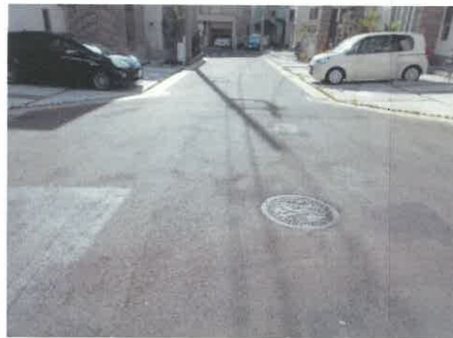
現況写真② (終点付近)
