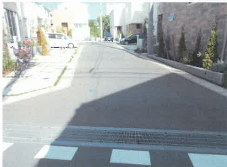
現況写真① (起点付近)
