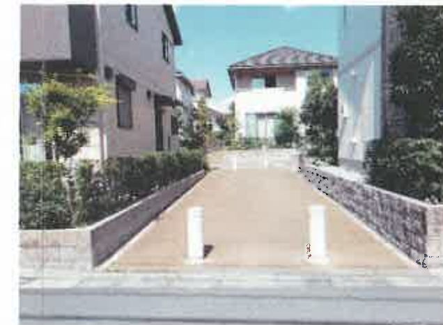
現況写真④ (37525号線起点付近)
