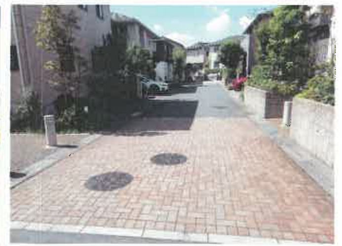
現況写真④ (37119号線中間付近)
