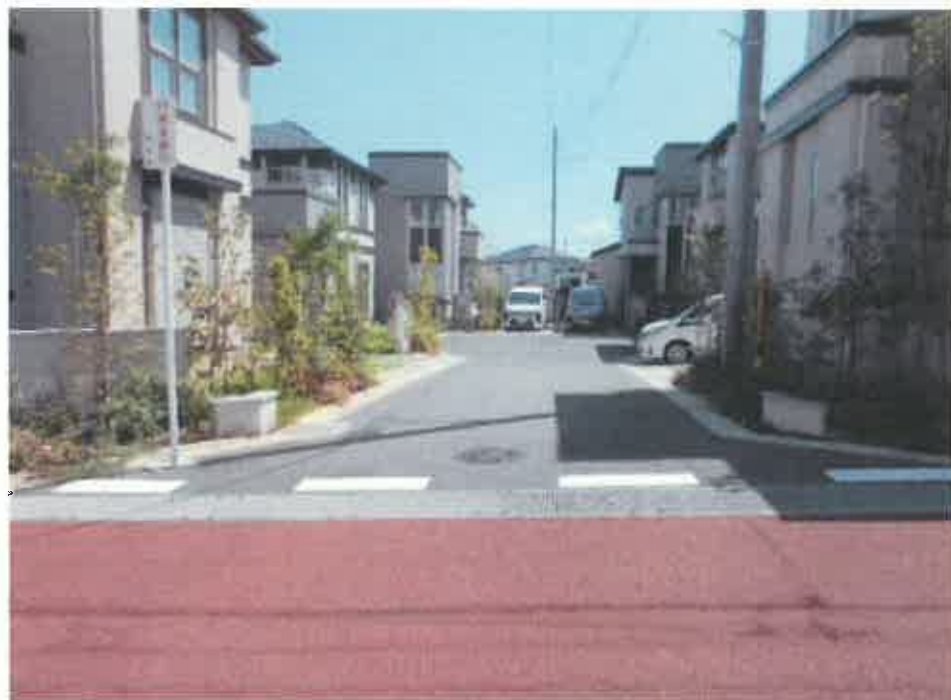
現況写真① (起点付近)
