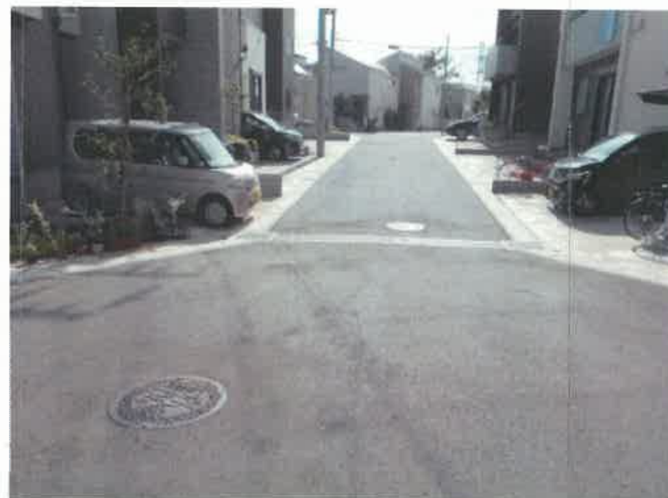
現況写真② (終点付近)
