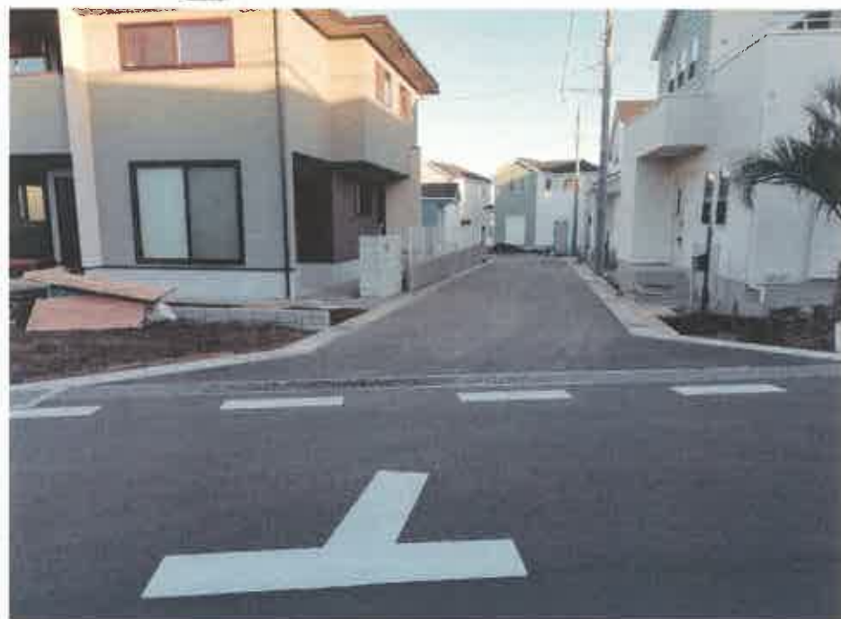
現況写真① (起点付近)
