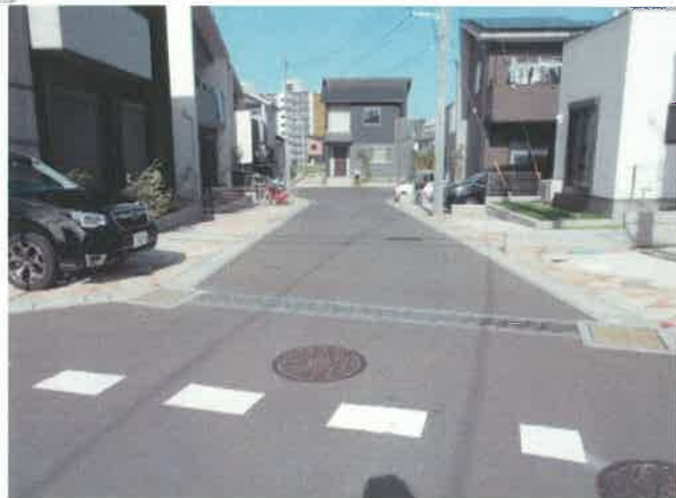
現況写真① (起点付近)
