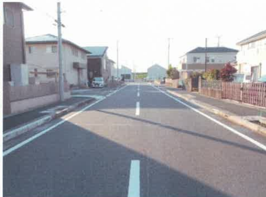
現況写真② (中間付近)
