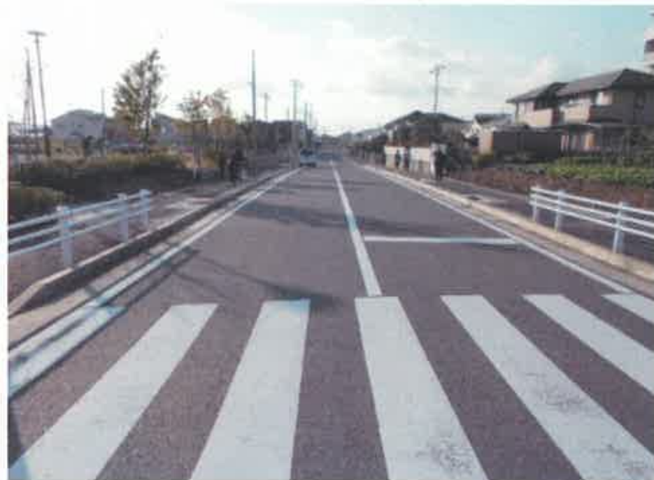
現況写真① (起点付近)
