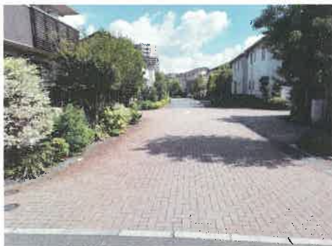
現況写真① (37114号線終点付近)
