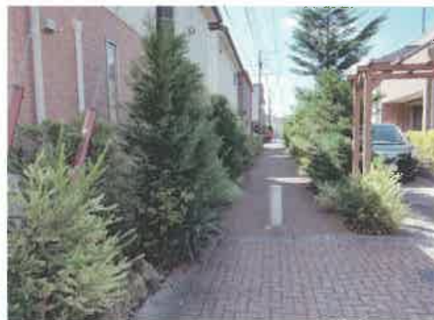
現況写真① (37520号線起点付近)
