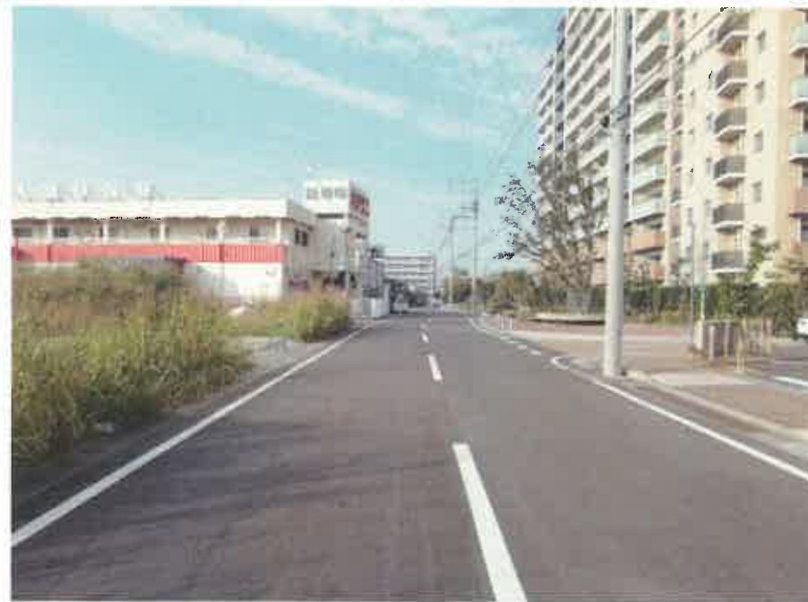
現況写真② (中間付近)
