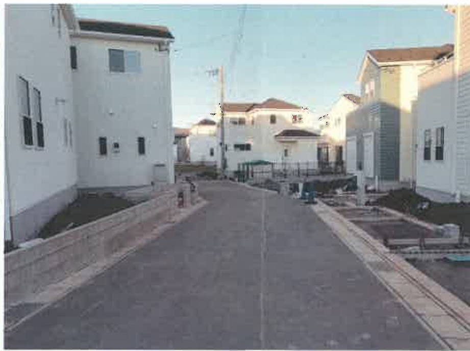
現況写真② (中間付近)
