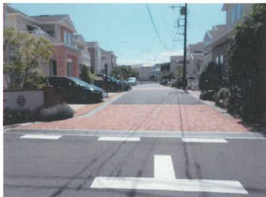
現況写真① (起点付近)
