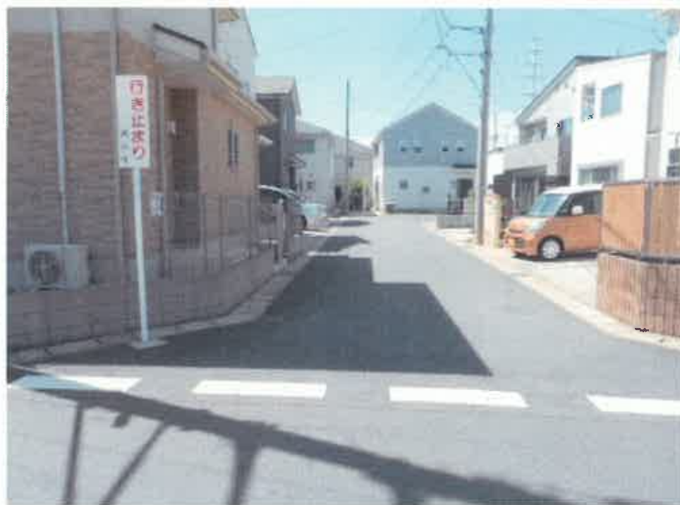
現況写真① (起点付近)
