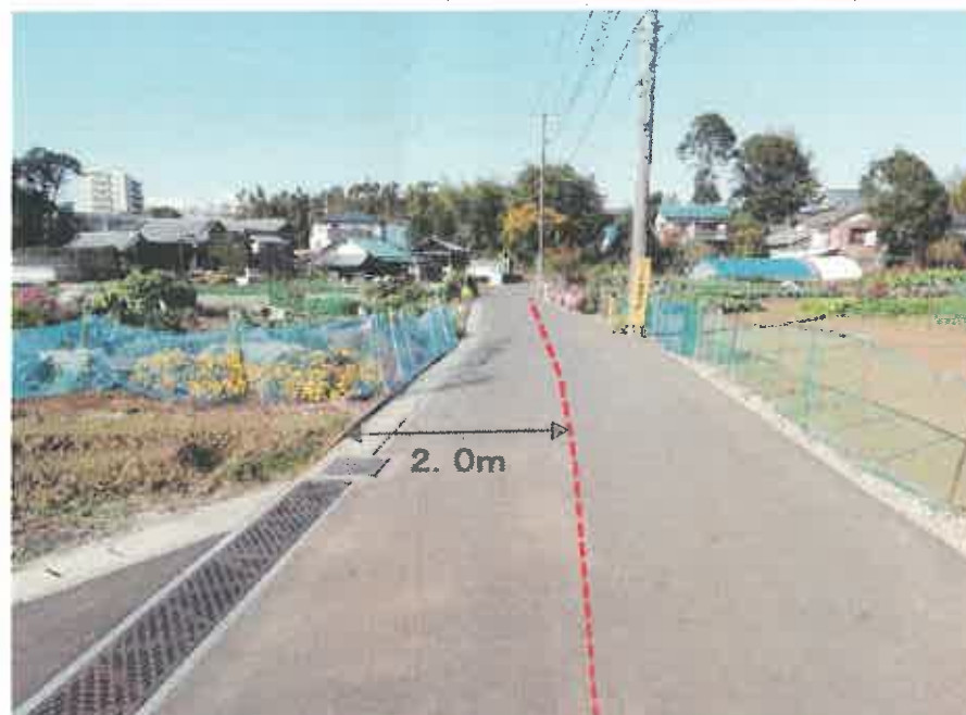
現地写真（A-A' 箇所）
