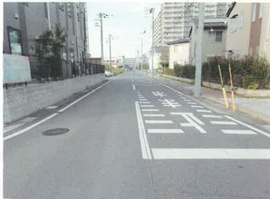
現況写真① (起点付近)
