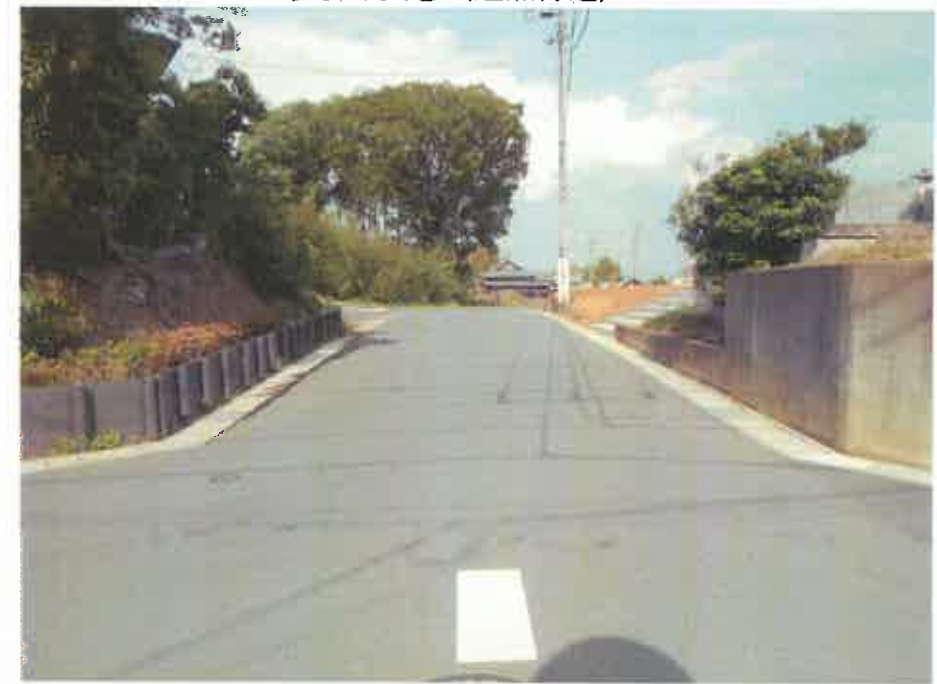
現況写真① (起点付近)
