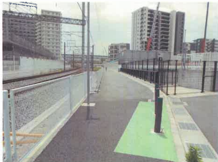
現況写真① (起点付近)
