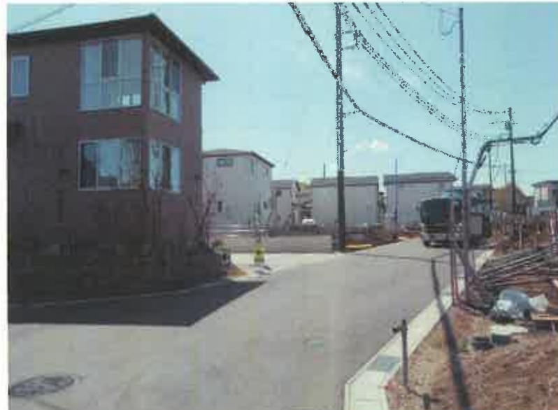
現況写真②(84086号線終点付近)
