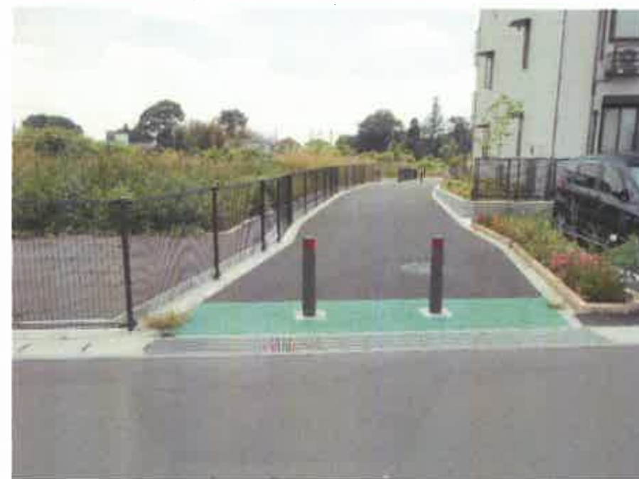
現況写真② (終点付近)
