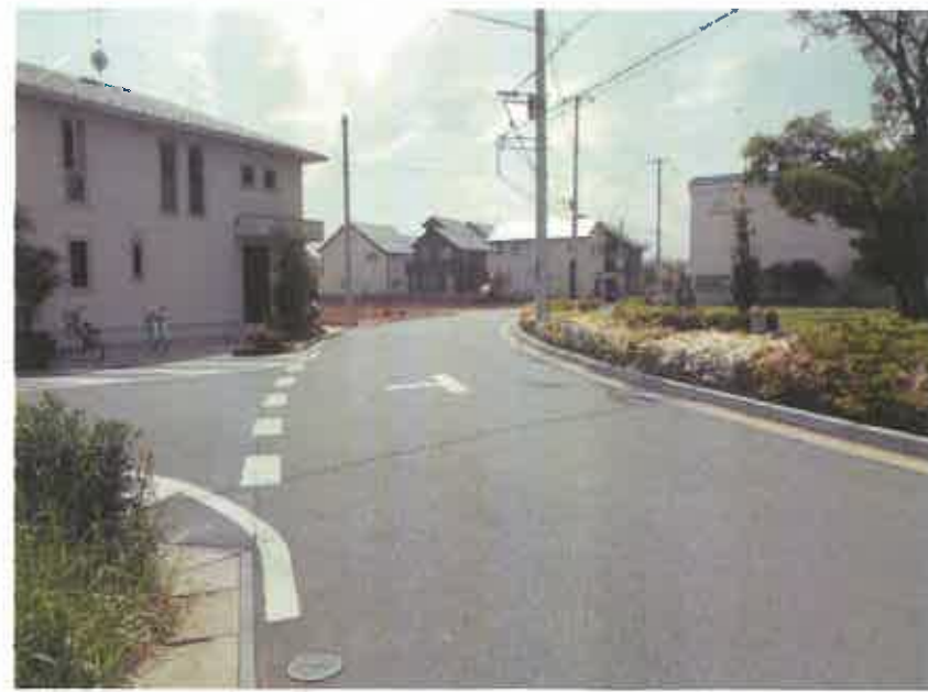
現況写真② (中間付近)
