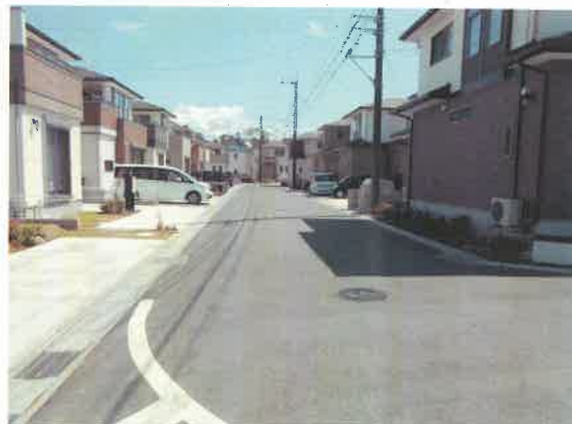
現況写真② (中間付近)
