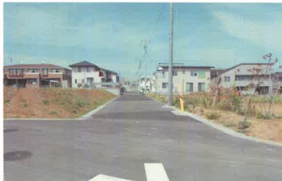
現況写真① (起点付近)
