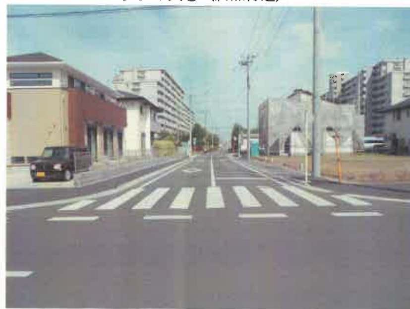
現況写真② (終点付近)
