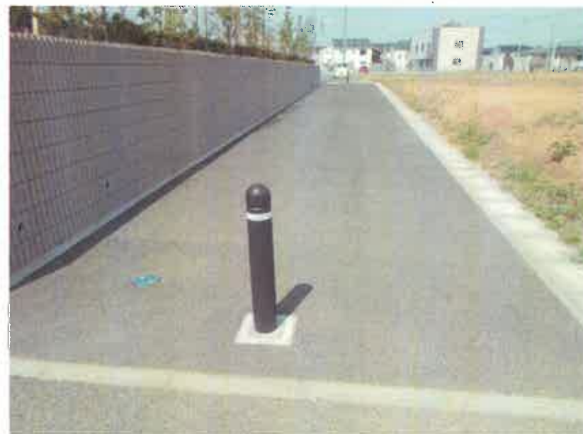
現況写真② (終点付近)
