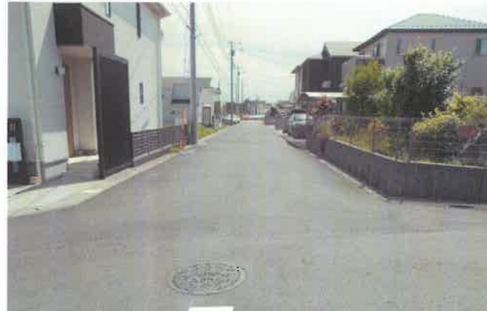
現況写真② (終点付近)
