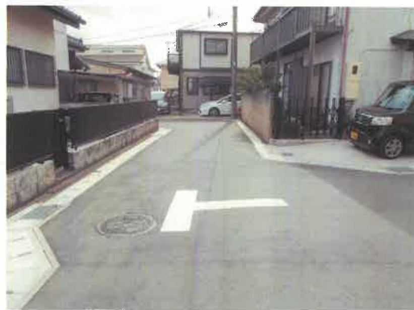
現況写真②(中間付近)
