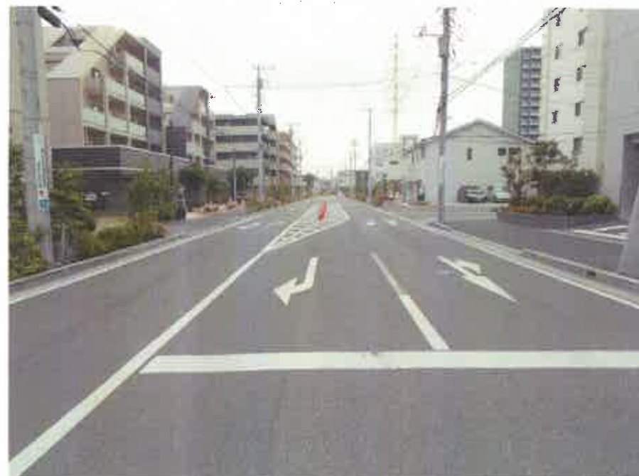
現況写真② (終点付近)
