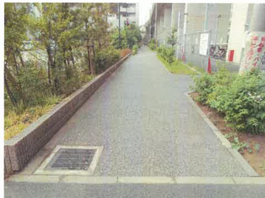
現況写真② (終点付近)
