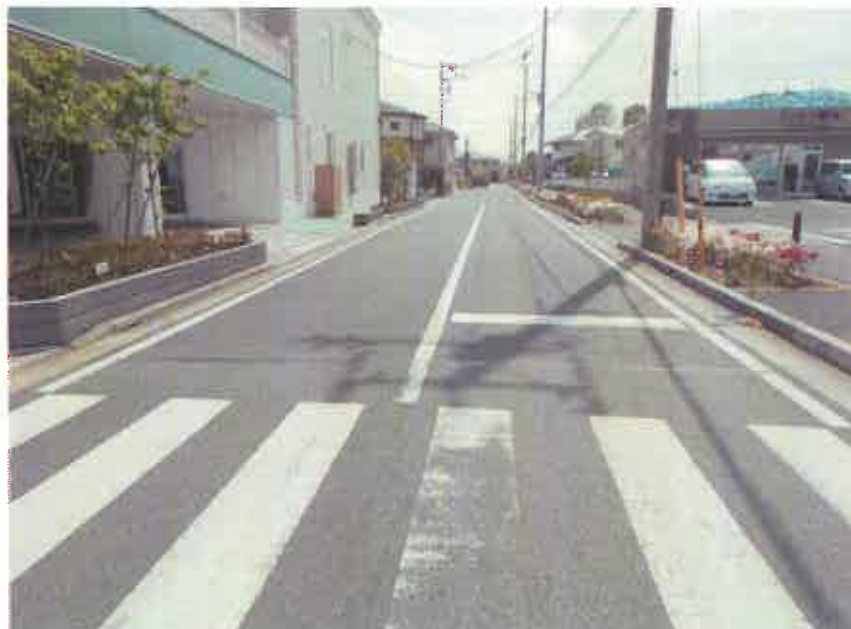
現況写真① (起点付近)
