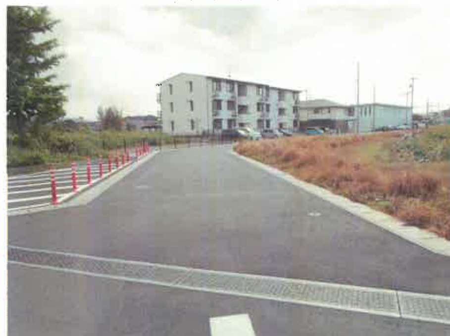
現況写真②(終点付近)
