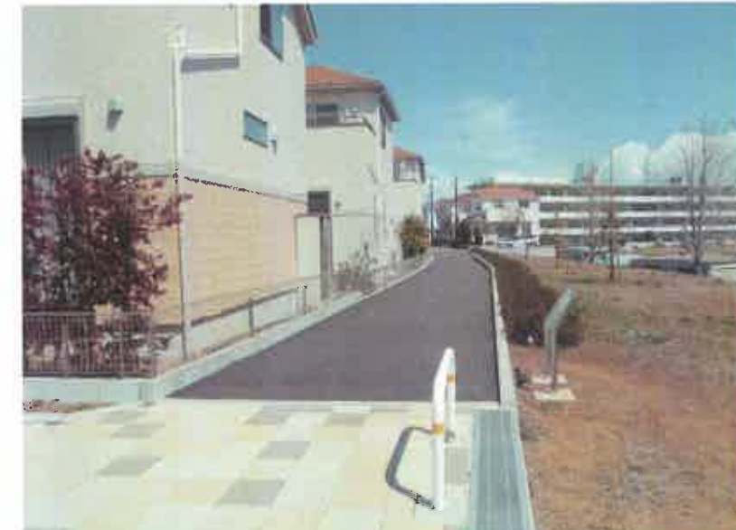
現況写真③(84504号線終点)
