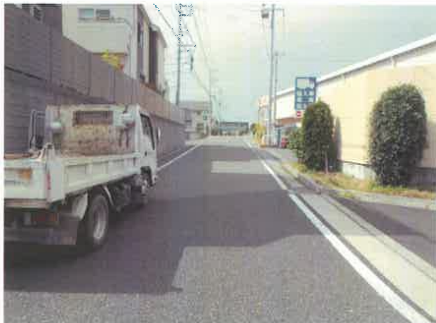
現況写真① (起点付近)
