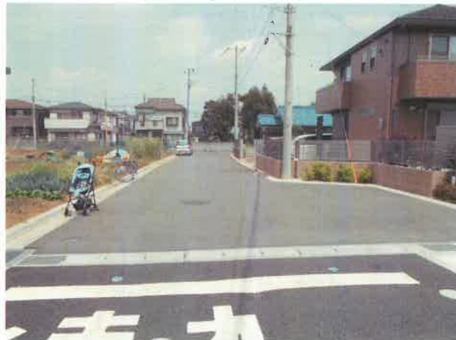
現況写真②(終点付近)
