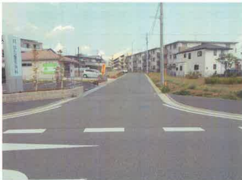
現況写真① (起点付近)
