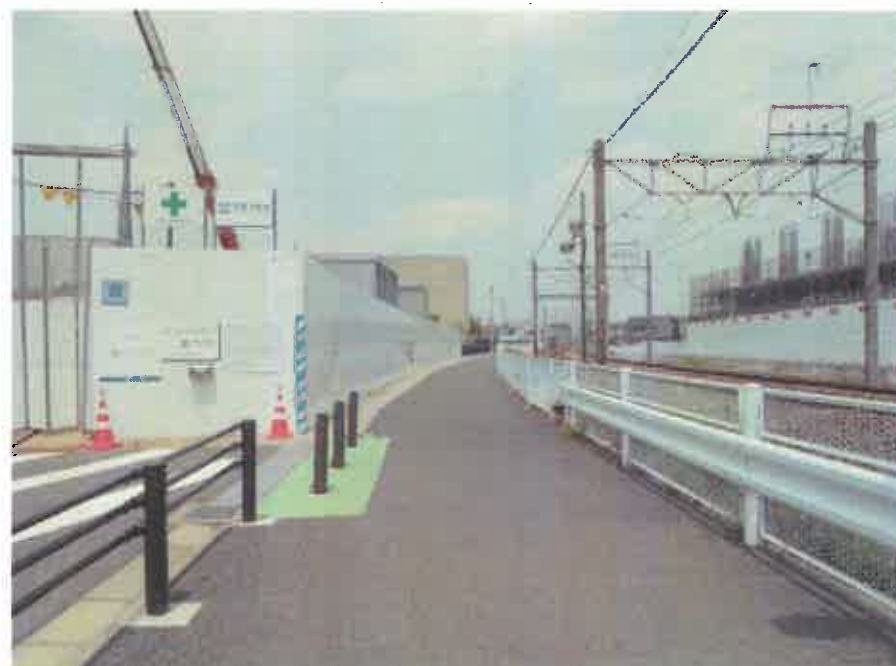
現況写真② (終点付近)
