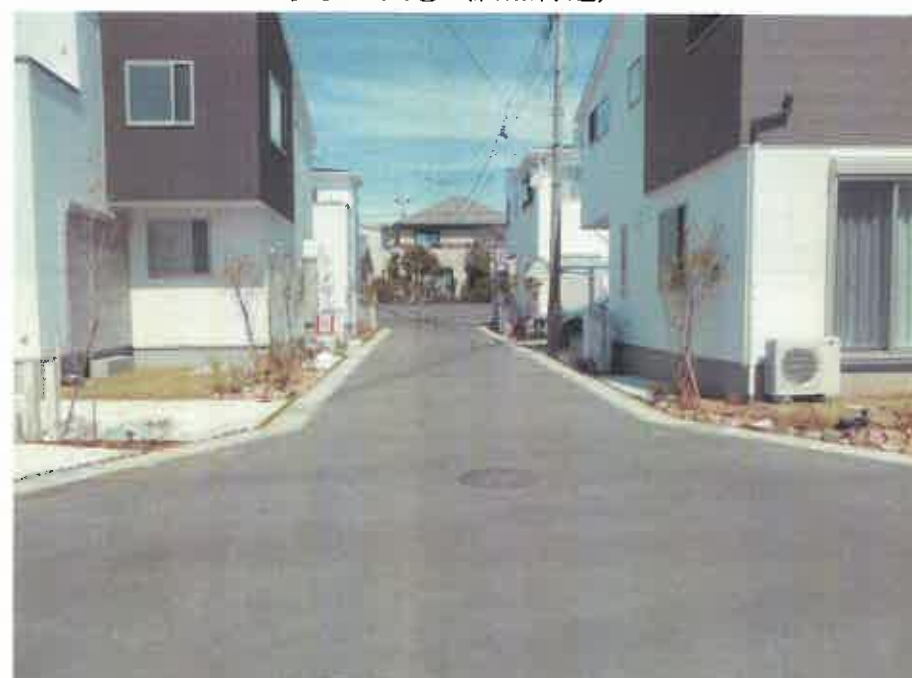
現況写真② (終点付近)
