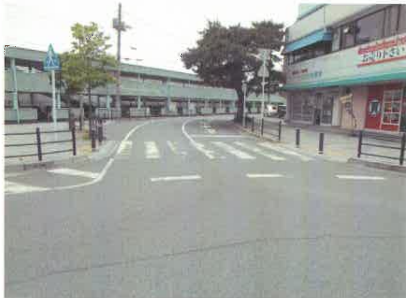
現況写真① (起点付近)
