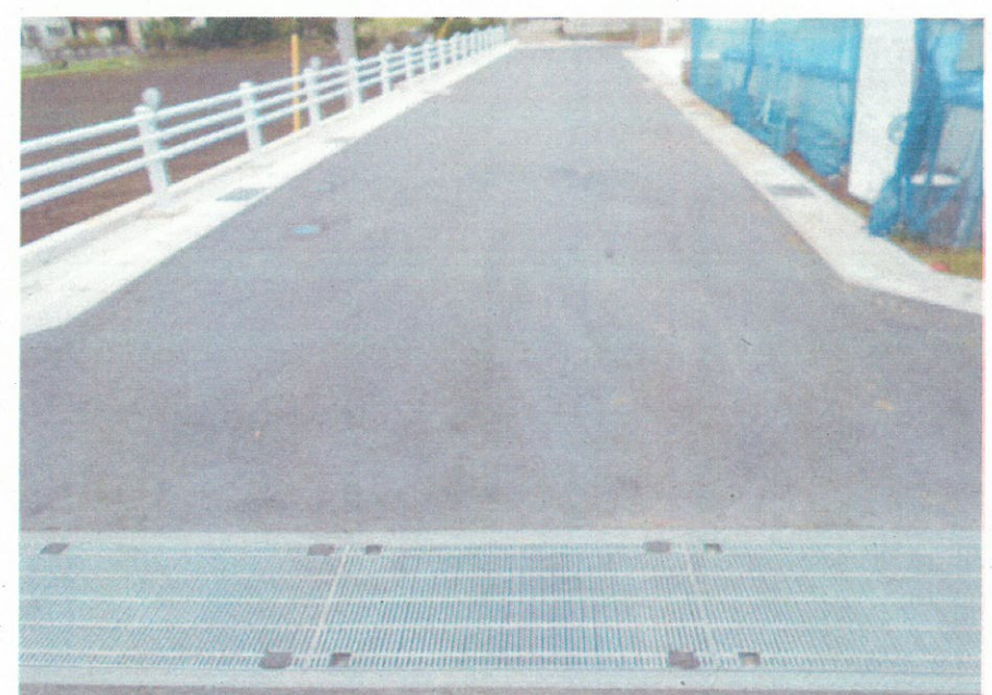
③現況写真（終点付近）
