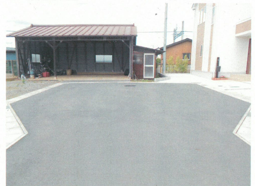
現況写真(終点付近)
