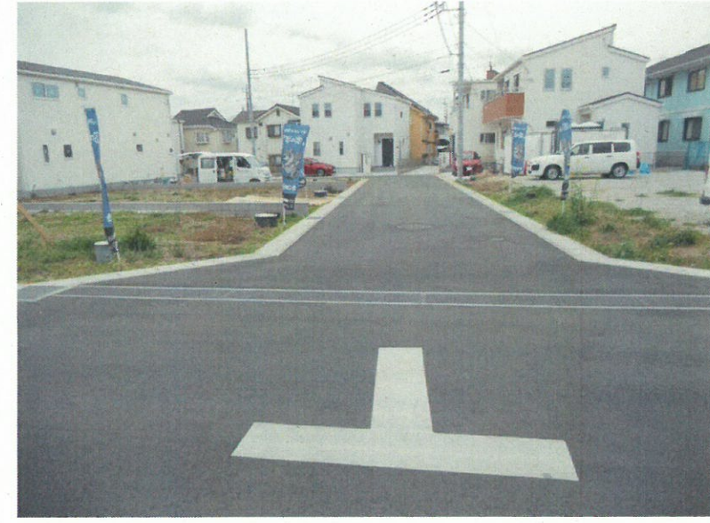
現況写真(終点付近)
