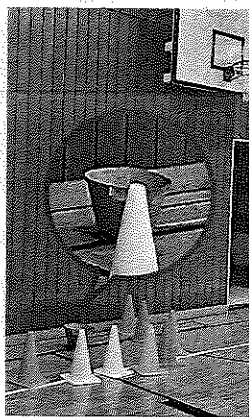
西初石中学校の体育館では、雨漏りが…。応急工事が実現しました。
