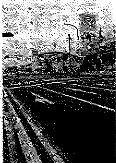
横断歩道・右折レーンの表示 塗りなおし(国道6号) 高橋あきら
