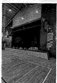
体育館スペース増築へ（八木北小学校） 小田 桐たかし
