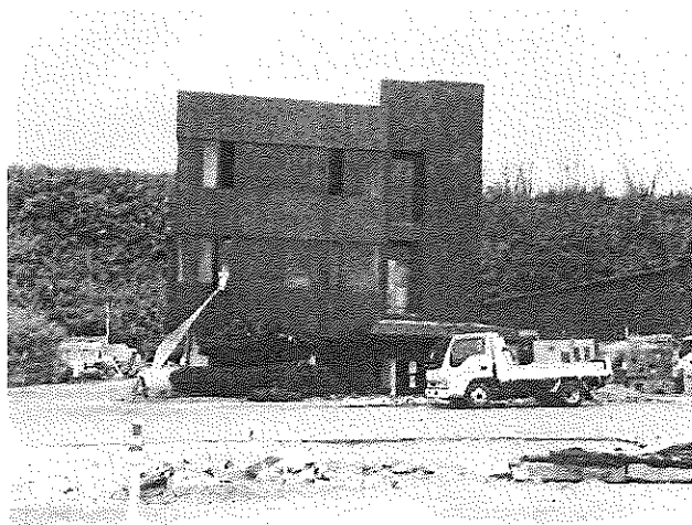
3階建てビルの陥没
