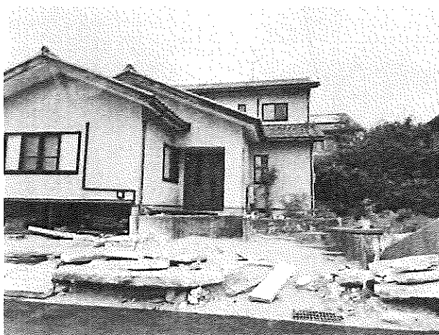
住宅本体は、大きな損傷はない
