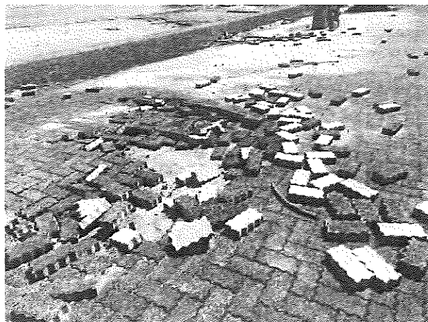
液状化による噴砂跡
