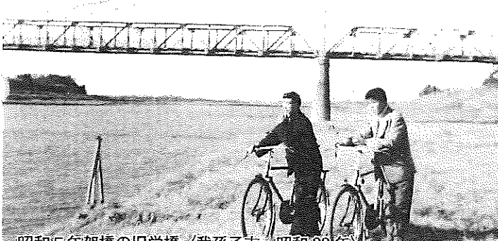
昭和5年架橋の旧栄橋（我孫子市・昭和29年）
