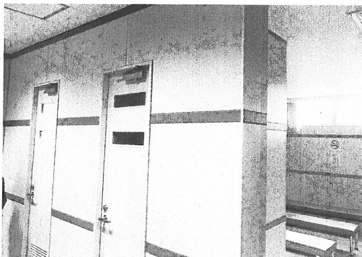
更衣室に新設したトイレ
