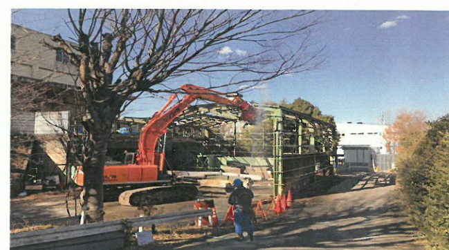
粉砕機処理棟解体状況
