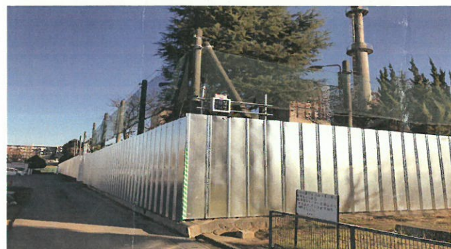
仮囲い完了 (北側)
