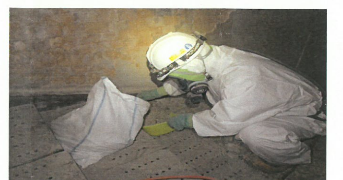
S41年焼却施設ダイオキシン類除染 状況 (灰出し作業)
