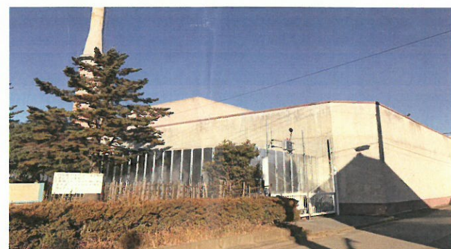
仮囲い完了 (西側)
