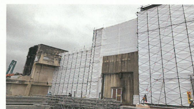
S41年焼却施設ダイオキシン類除染 養生完了状況
