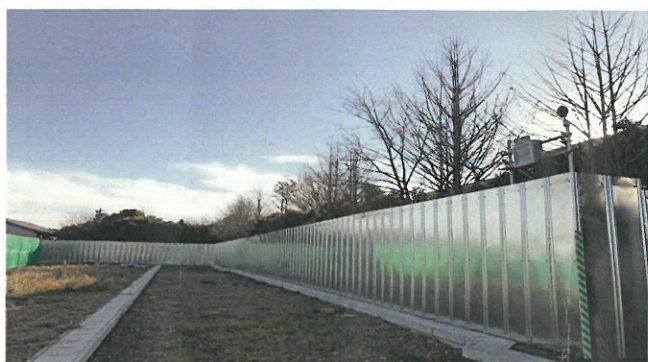
仮囲い完了 (東側)
