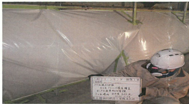
S51年焼却施設3工区吹付石綿 除去養生完了検査立会
