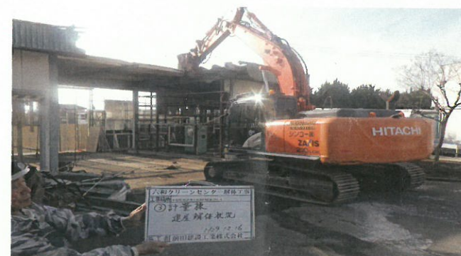
計量棟解体状況
