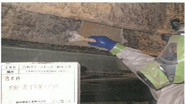
S51年焼却施設3工区吹付石綿 除去状況
